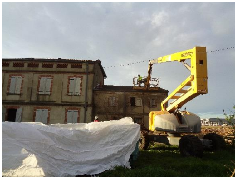
Figure 44 : Exemple d'une dépose de tuiles réalisée à l'aide d'une nacelle
