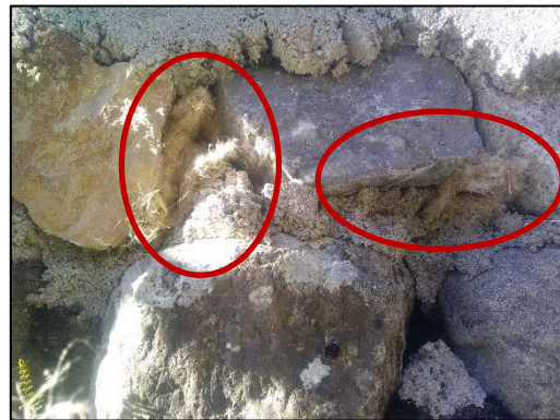
Figure 42 : Obturation de cavités à l'aide de chanvre naturel
