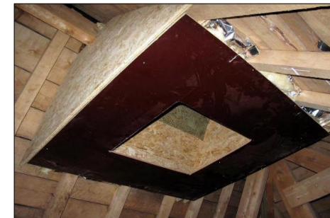
Figure 52 : Construction d'un caisson isolé de la toiture (Conservation du patrimoine naturel du bassin de la Chiers en Lorraine belge et française)
