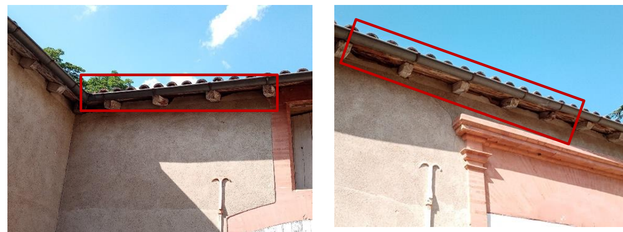
Figure 41 : Parties délitées au niveau des façades des dépendances
