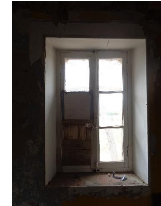
Figure 45 : Partie délitée d'une porte et fenêtre obturées avec des plaques en bois et en carton jusqu'au moment des travaux
