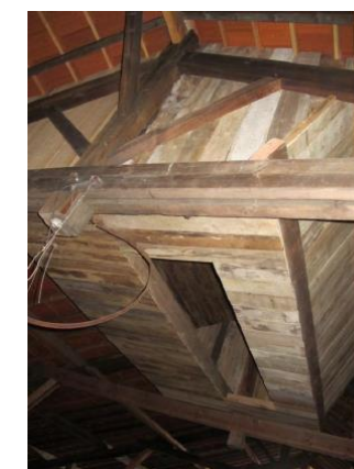
Figure 54 : Exemple d'une « Hot box » réalisée construite dans une grande en vue d'accueillir le Grand rhinolophe (SFPEM, 2015)
