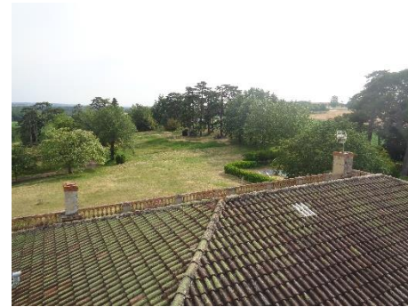
Figure 26 : Toiture de la Maison de maître favorable aux chauves-souris
