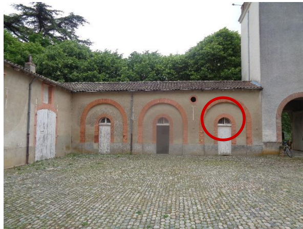
Figure 57 : Fenêtre ouverte permettant l'accès des oiseaux à l'intérieur de la pièce de stockage
