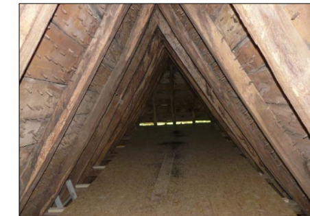
Figure 53 : Exemple de caisson non isolé de la toiture (SFPEM, 2015)
