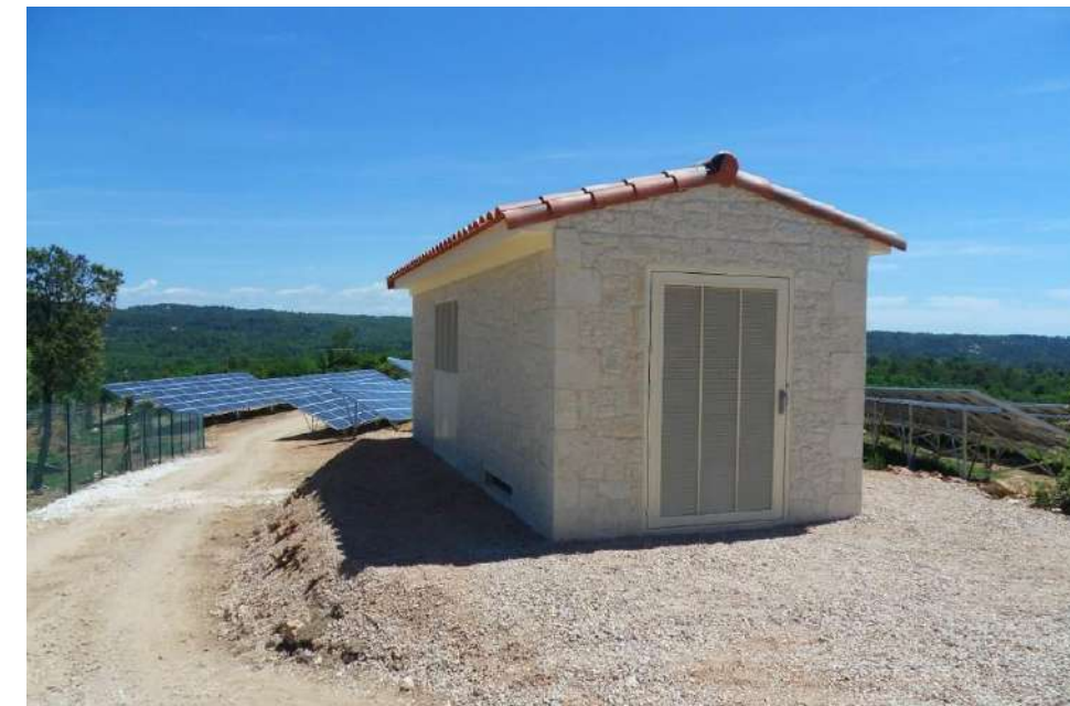
Exemple de poste de livraison (habillage pierre spécifique au parc solaire de Montmayon pour une meilleure intégration paysagère) – Source VOLTALIA
