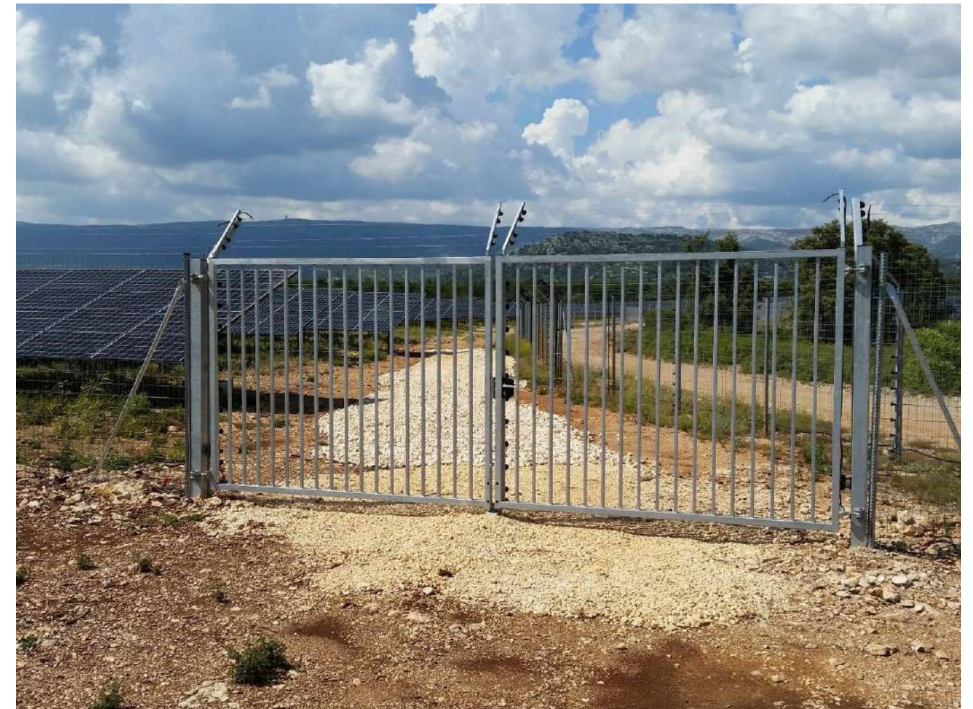
Figure 13 : Exemple de portail à battant- Parc solaire de Castelet - VOLTALIA
