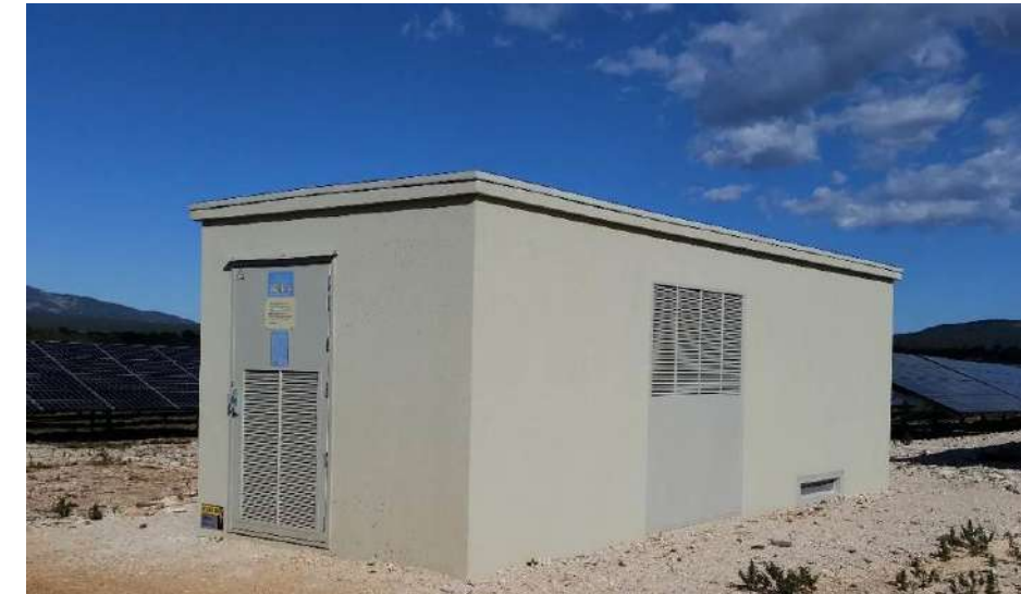
Exemple de poste de transformation – Parc solaire du Castelet – Source : VOLTALIA
