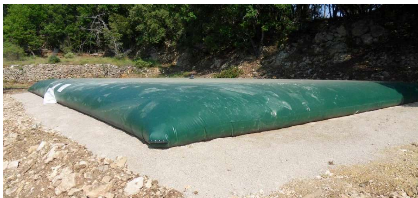
Figure 14 : Exemple de citerne souple de 120m 3 du parc solaire de Montmayon – source VOLTALIA
