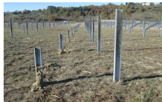
Figure 7. Ancrage de pieux battus
