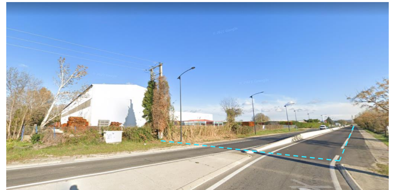
Figure 20. Photographie de la ligne électrique HT à l'endroit où le raccordement de la centrale de Beaucaire Domitia (pointillés bleus) est pressenti, à l'extrémité Ouest de la ZIP de Beaucaire Domitia, au bord de la RD90 (Source : Google Street View)
