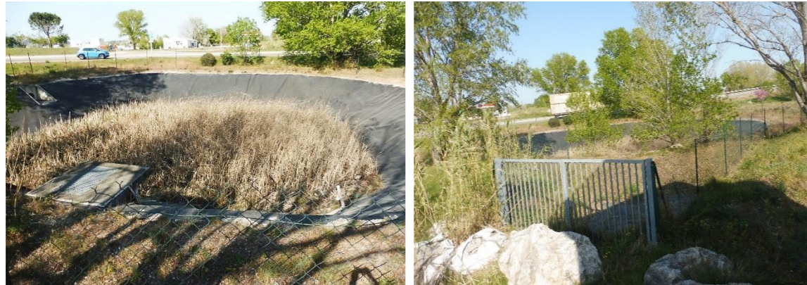
Bassin de rétention
