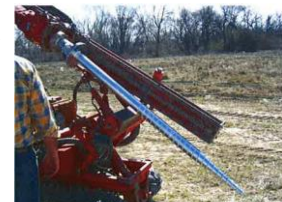
Figure 6. Mise en œuvre de pieux
