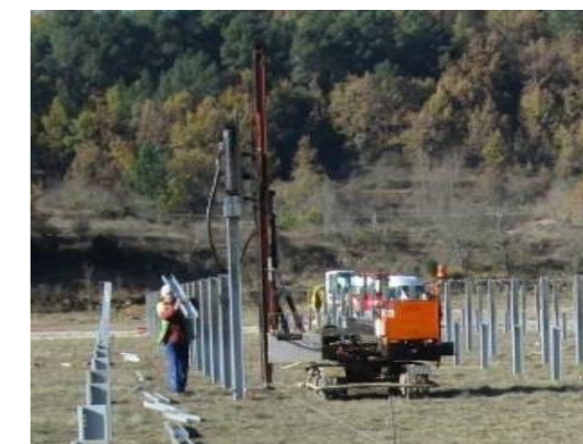
Figure 8. Battage de pieux
