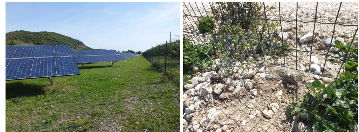
Clôture surélevée d'environ 10 cm par rapport au sol
