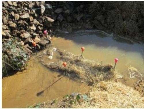
Figure 3 : A gauche, filtre à paille non fonctionnel, à droite, filtre à paille et barrière minérale efficaces (© ECOTONE)
