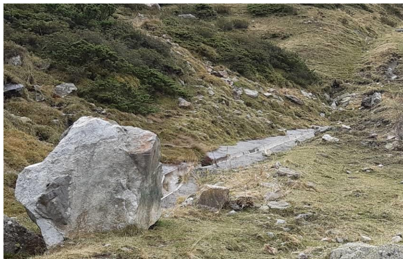
Figure 36 : Caniveau en béton existant le long du siphon
