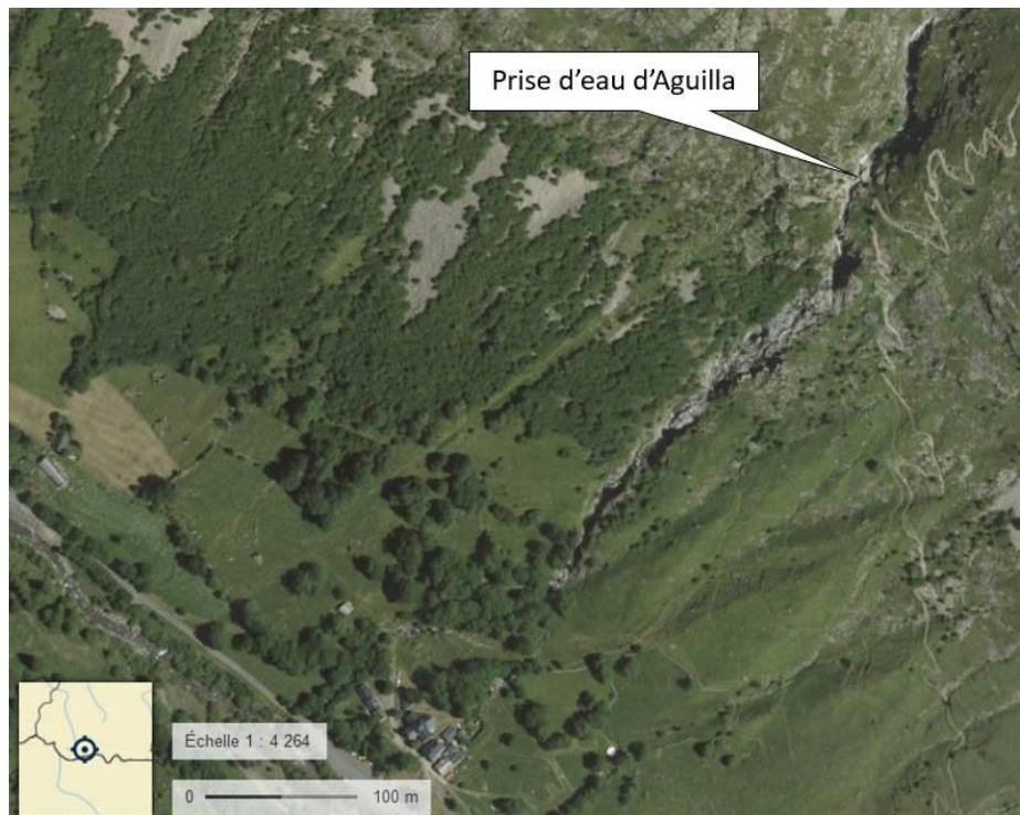
Figure 13 : Localisation de la prise d'eau d'Aguilla
