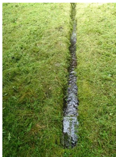
Figure 25 : Exemple de fossé drainant existant qui présente une attractivité écologique
