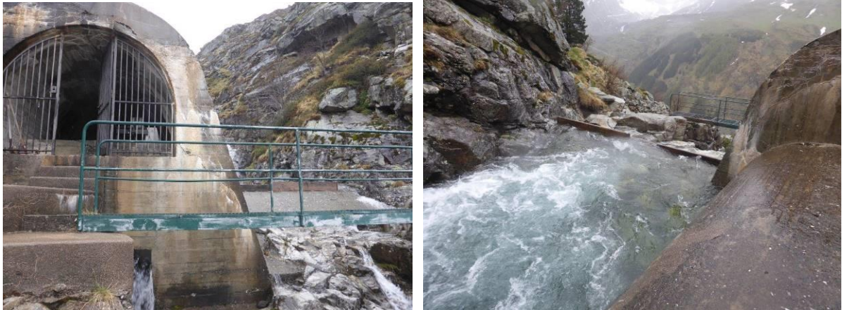
Figure 15 : La prise d'eau d'Aguila vue depuis l'aval et depuis l'amont
