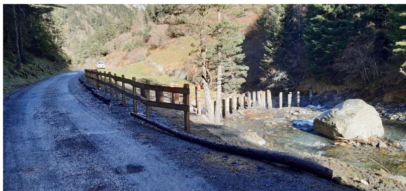
Figure 48 : piège à bois existant en amont de la retenue
