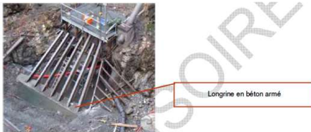
Figure 45 : longrine béton à réhabiliter
