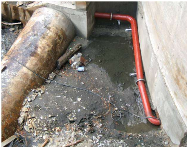
Figure 6 : localisation du piquage du débit réservé sur la galerie prise d'eau
