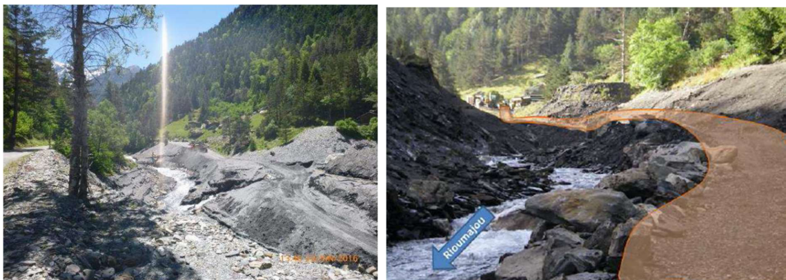
Figure 36 : réhabilitation de la piste d'accès existante en rive gauche
