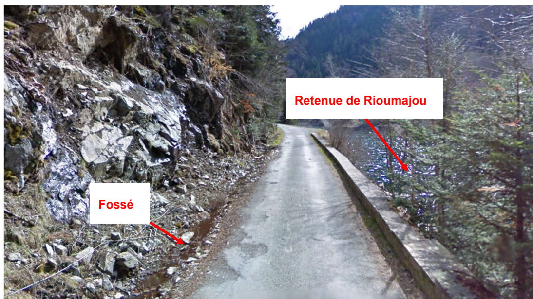
Figure 28 : Localisation du fossé drainant en bordure de retenue
