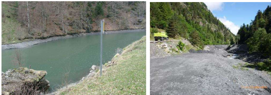
Figure 18 : Retenue de Rioumajou en exploitation normale et en phase de vidange
