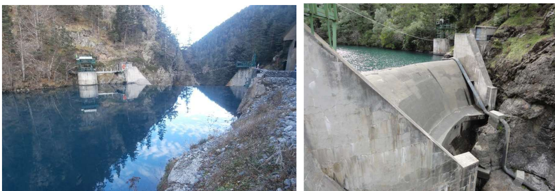
Figure 4 : vue du barrage de puis l'amont (à gauche) et depuis l'aval (à droite)
