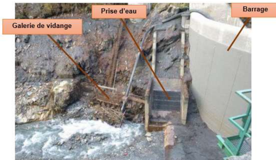
Figure 5 : vue de la galerie de vidange et de la prise d'eau
