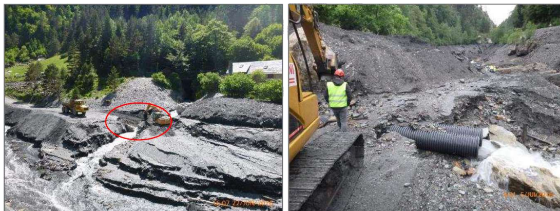
Figure 38 : Mise en place du passage busé sur le Barricave en 2016
