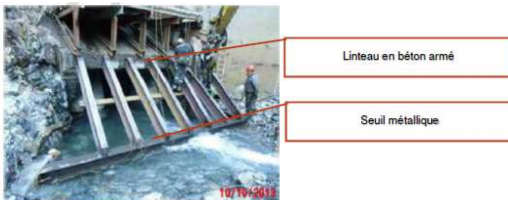
Figure 44 : dépose du plan de grille existant et du seuil métallique
