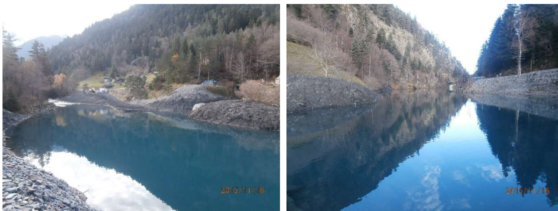
Figure 7 : Vue de la retenue vers l'amont (à gauche) et vers l'aval (à droite)
