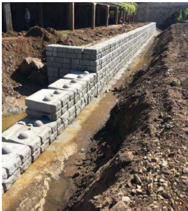
Figure 43 : Exemple d'utilisation des blocs béton pour un mur de soutènement
