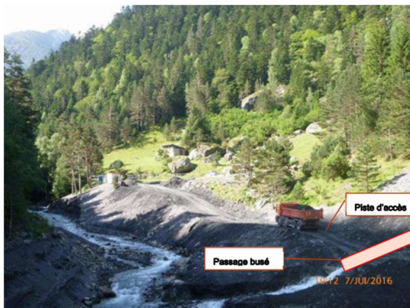
Figure 37 : insertion du passage busé au niveau du Barricave
