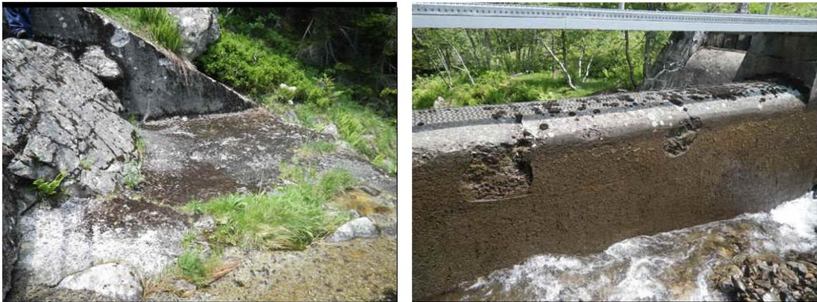
**Figure 21 : Radier aval (à gauche) et mur de la prise d'eau (à droite) à réparer**
