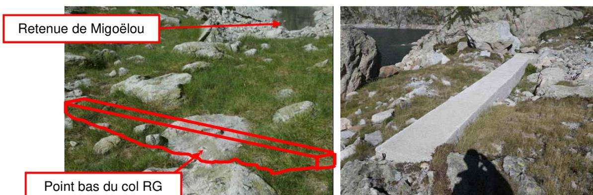
Figure 17 : réalisation d'un muret (à gauche) sur le modèle de murets existants (à droite)
