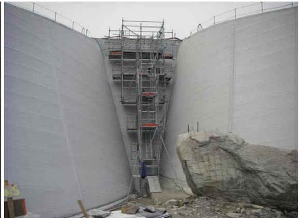
**Figure 14 : Mise en place de la géomembrane - Figure 15 : Echafaudage sur le parement amont**
