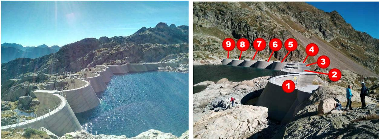
**Figure 5 : photo des voûtes du barrage de Migoëlou (sept. 2016)**
