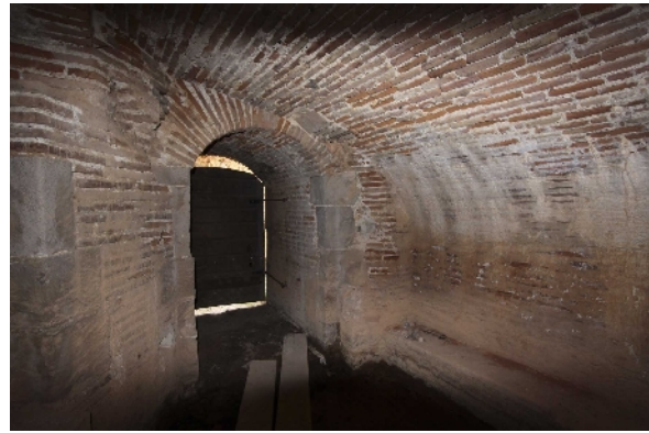
Figure 9: Poterne cavalerie (ancienne colonie de transit de Murins de Capaccini) et la porte laissant passer le jour. On remarque également les planches qui servent aux ouvriers pour passer des brouettes. (V. Rufray).
