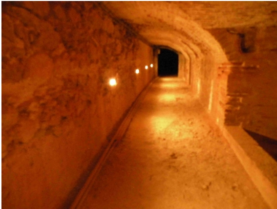
Figure 10: Eclairage permanent de la contremine Sud Ouest (F. Barbé)
