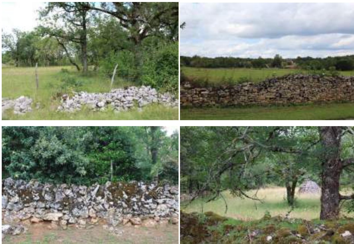
Exemples de murets dégradés dans le paysage (atopia)
