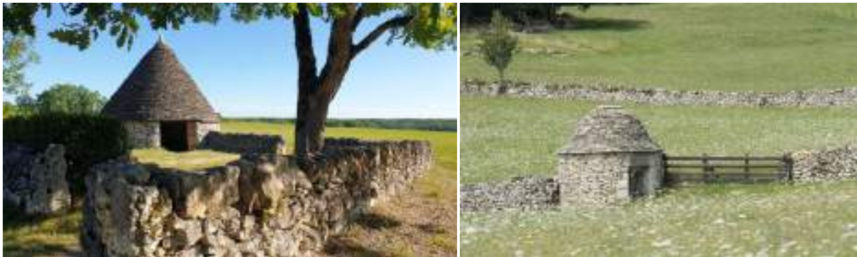
Caselle de Nouel à Lalbenque à gauche et caselle à Espédaillac à droite (site du PNRCQ)
