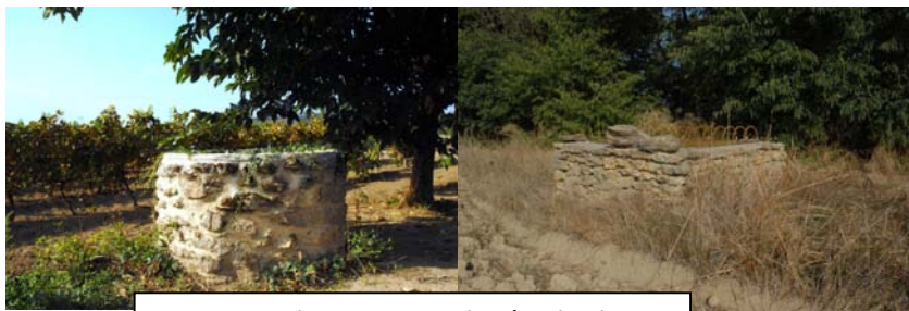
Murets en pierre assurant la sécurisation de l'ouverture de la cheminée
