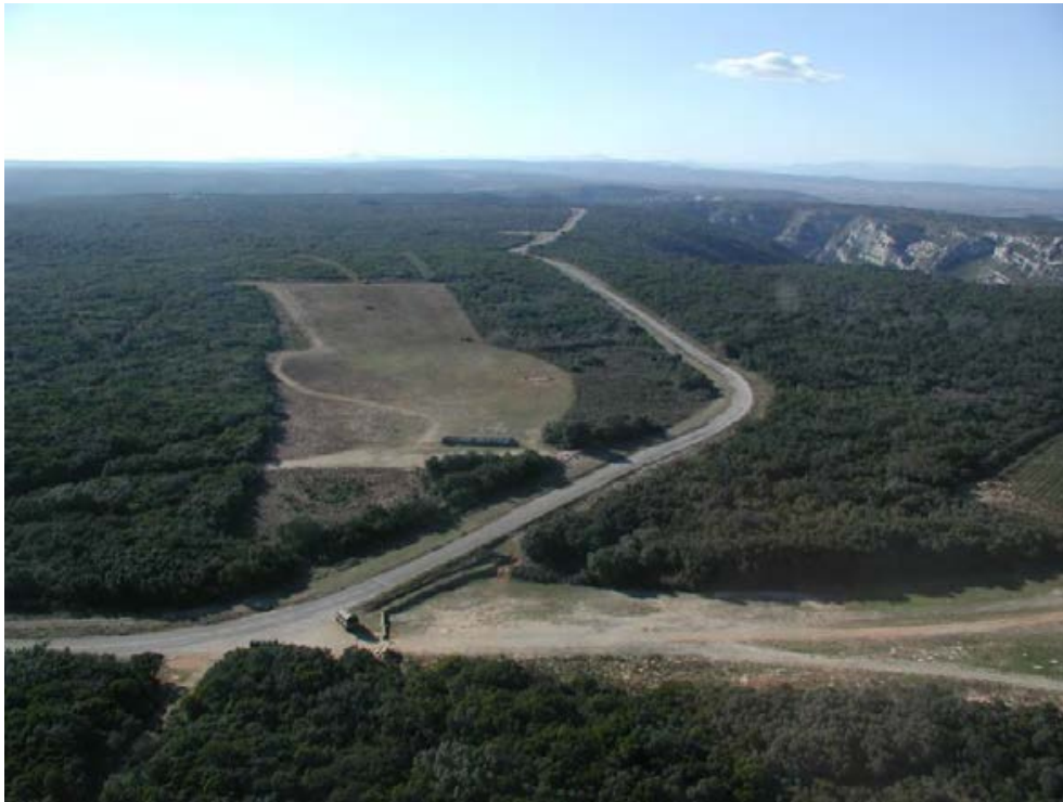
Figure 30 : Champ de tir et gorges du Gardon vus du ciel (source : camp des Garrigues)
