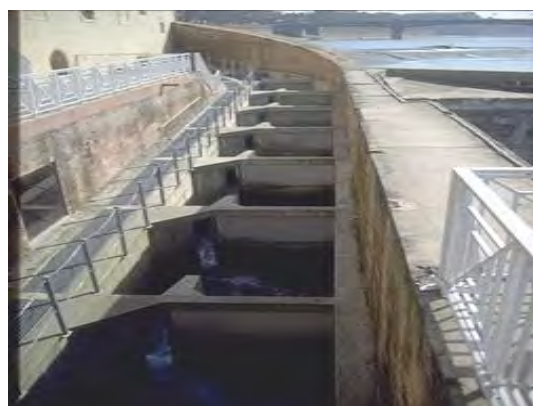
Passé à bassins successifs (pour la montaison) au Bazacle (MIGADO ©)
