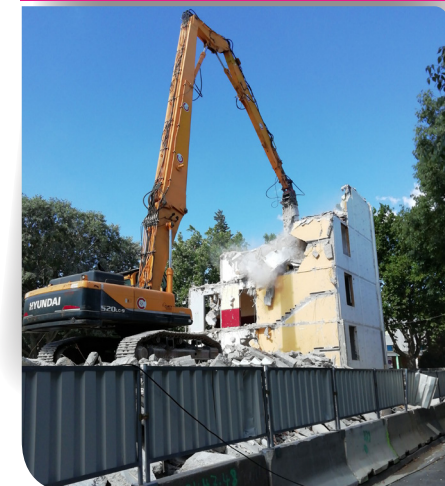
DÉMOLITION DE 80 LOGEMENTS À LA BOULE D'OR
