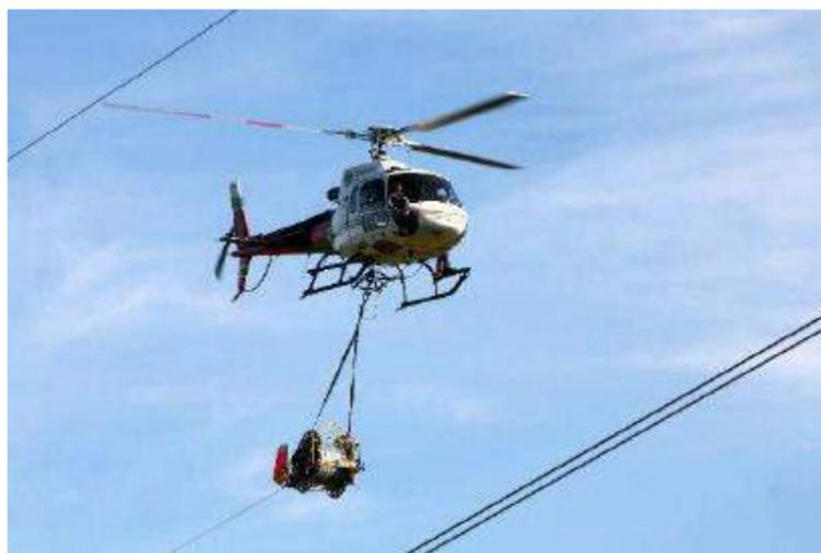
Figure 64 : Photo d'un déroulage de drisse par hélicoptère
