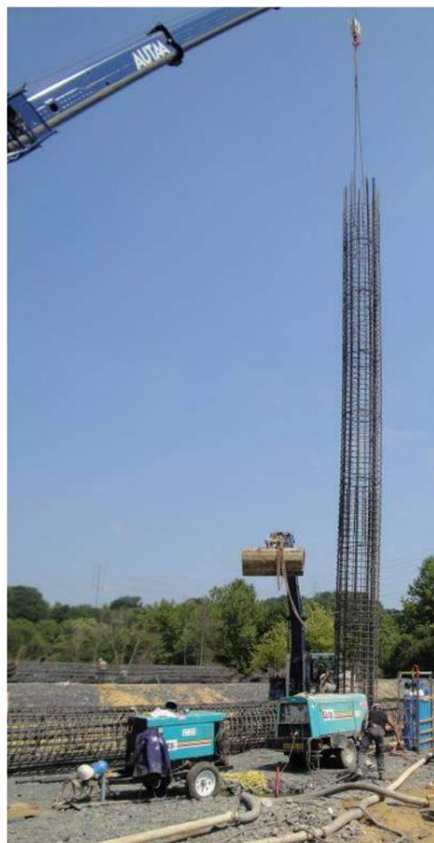
Figure 44 : Mise en place de la cage d'armatures (source : Groupement POMA, 2016)
