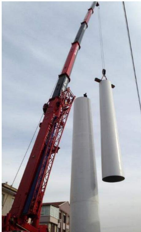
Figure 48 : Montage en cours d'un pylône de type éolien (source : Groupement POMA, 2016)
