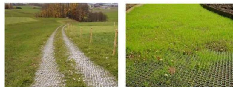
Figure 33 : Exemples de chemins avec dalles alvéolaires engazonnées (source : Groupement POMA, 2018)
