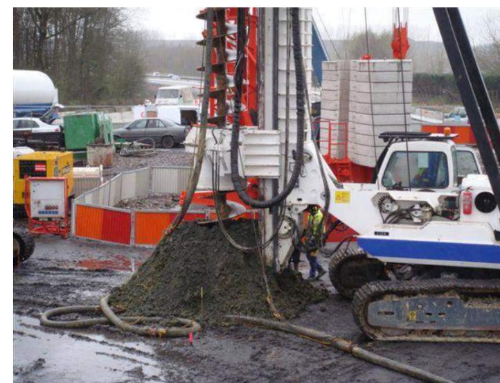
Figure 43 : Bétonnage d'un pieu à la tarière creuse (source : Groupement POMA, 2016)
