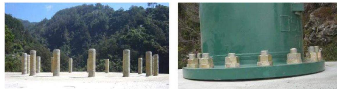
Figure 47 : Ancrage prêt à recevoir la base du pylône, puis pylône fixé au massif (source : Groupement POMA, 2016)
