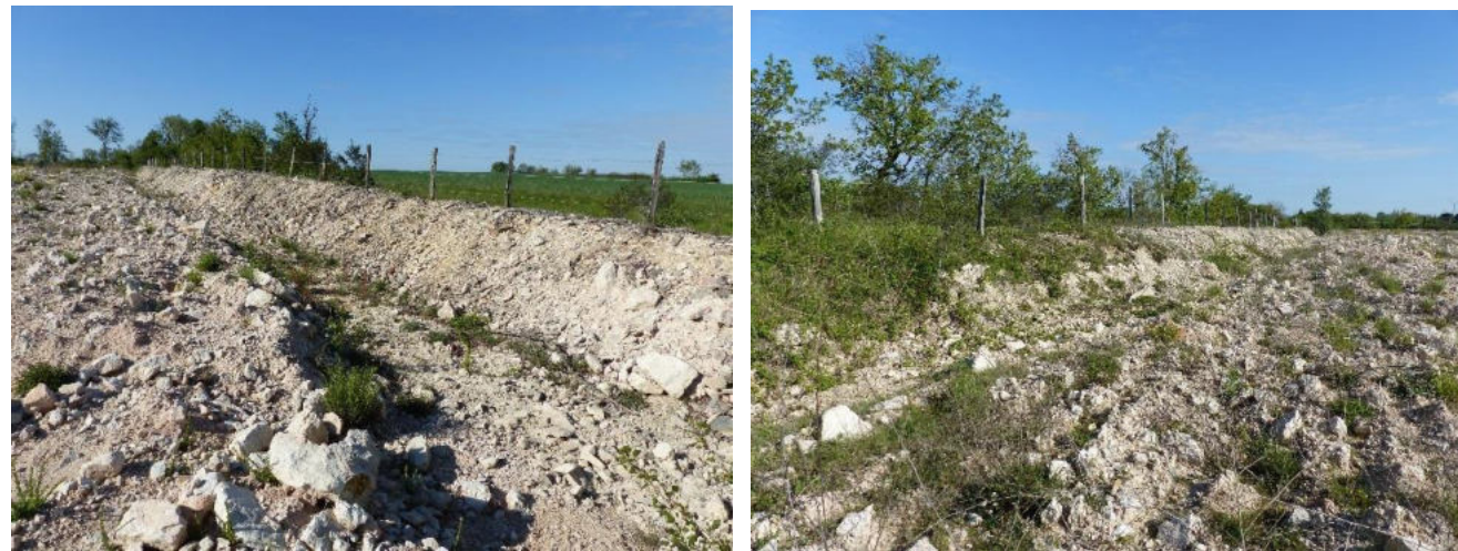
Talus présent sur l'aire d'étude © ECTARE
