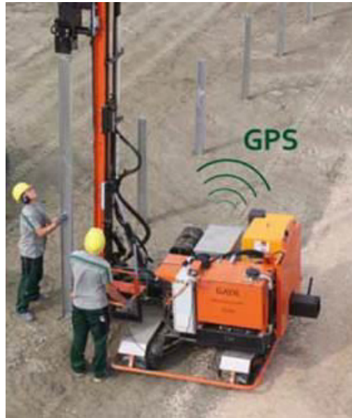
Illustration 2 : ancrage au sol par pieux battus
