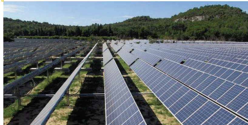
Photo 3 : Parc solaire équipé de technologie trackers (matinée, azimut de la photo : sud) Source : Exosun
