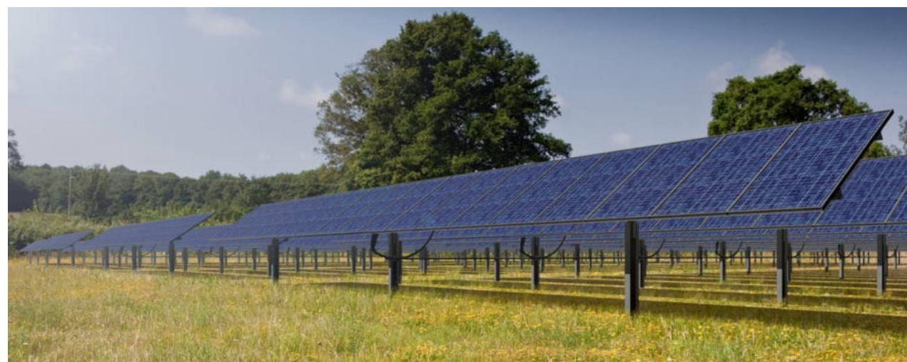
Une rangée de trackers (Source : Exosun)
