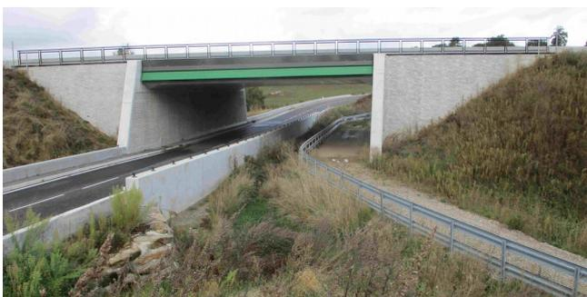
*Ouvrage mixte : rétablissement routier, rétablissement d'une continuité hydraulique, passage agricole, passage faune dont chiroptères*
