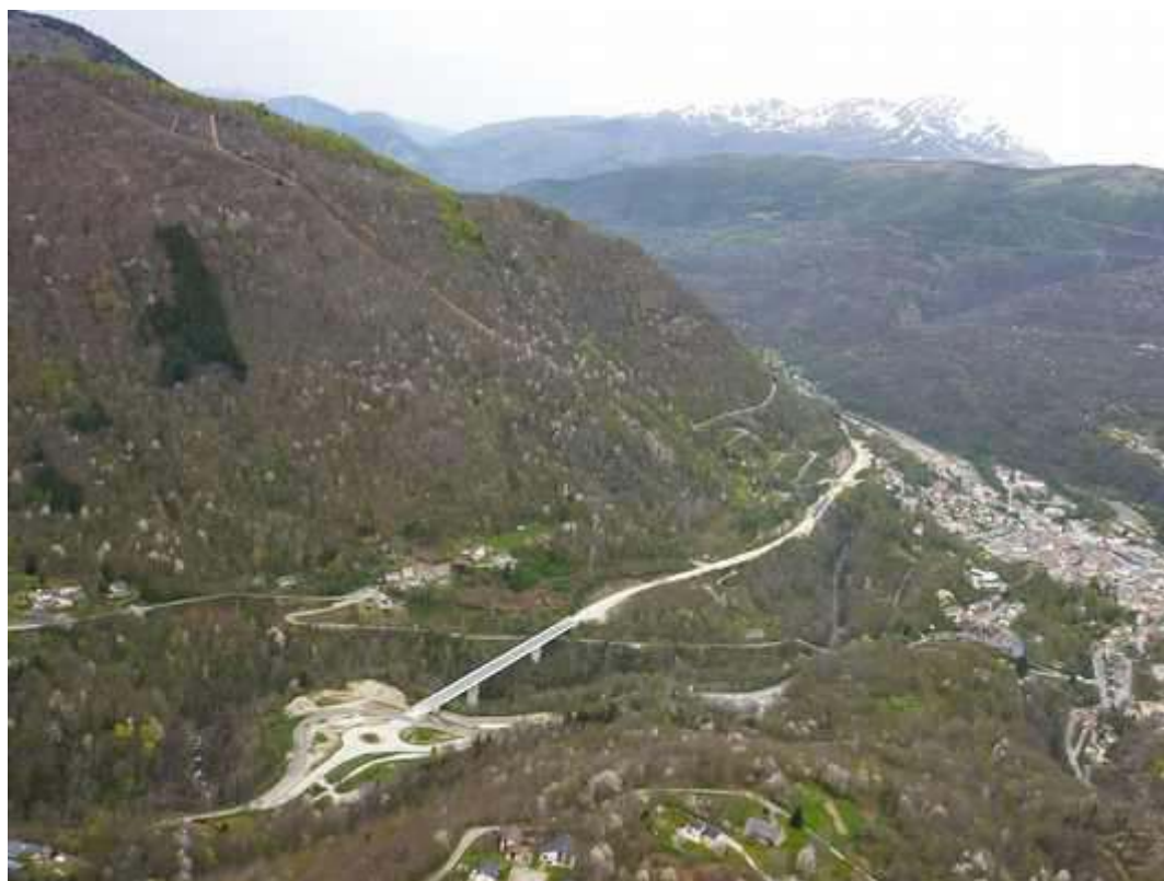
Vue aérienne de la déviation (carrefour giratoire sud et viaduc sur l'Ariège) – photo DREAL Occitanie
