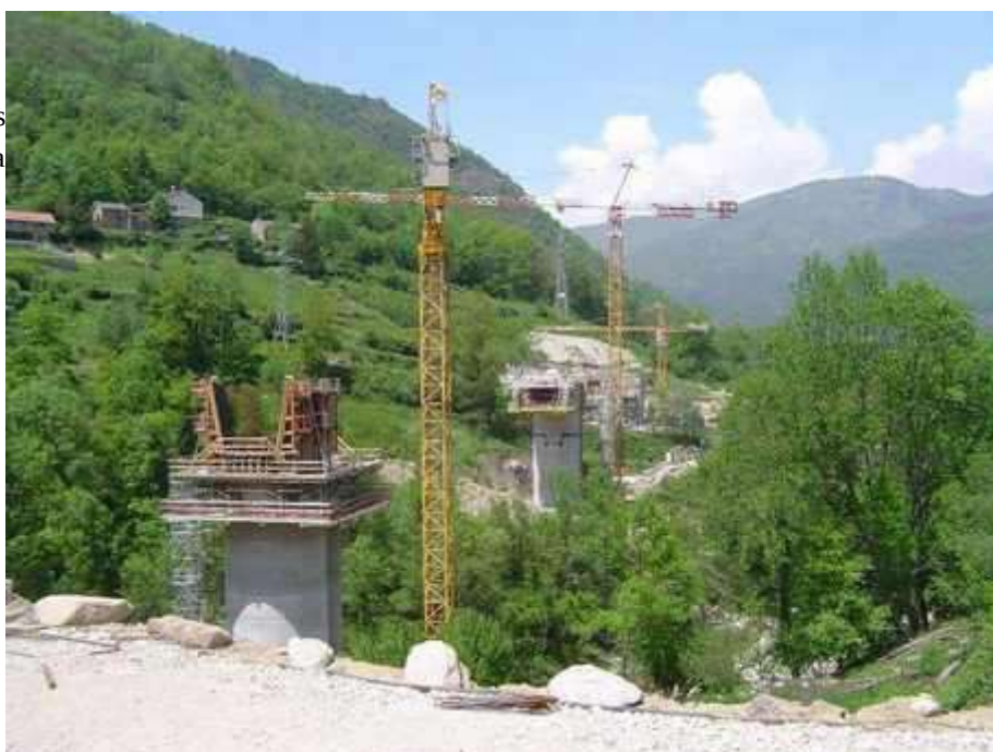
Réalisation des piles du viaduc sur l'Ariège avant la pose des caissons – photo DIRSO
