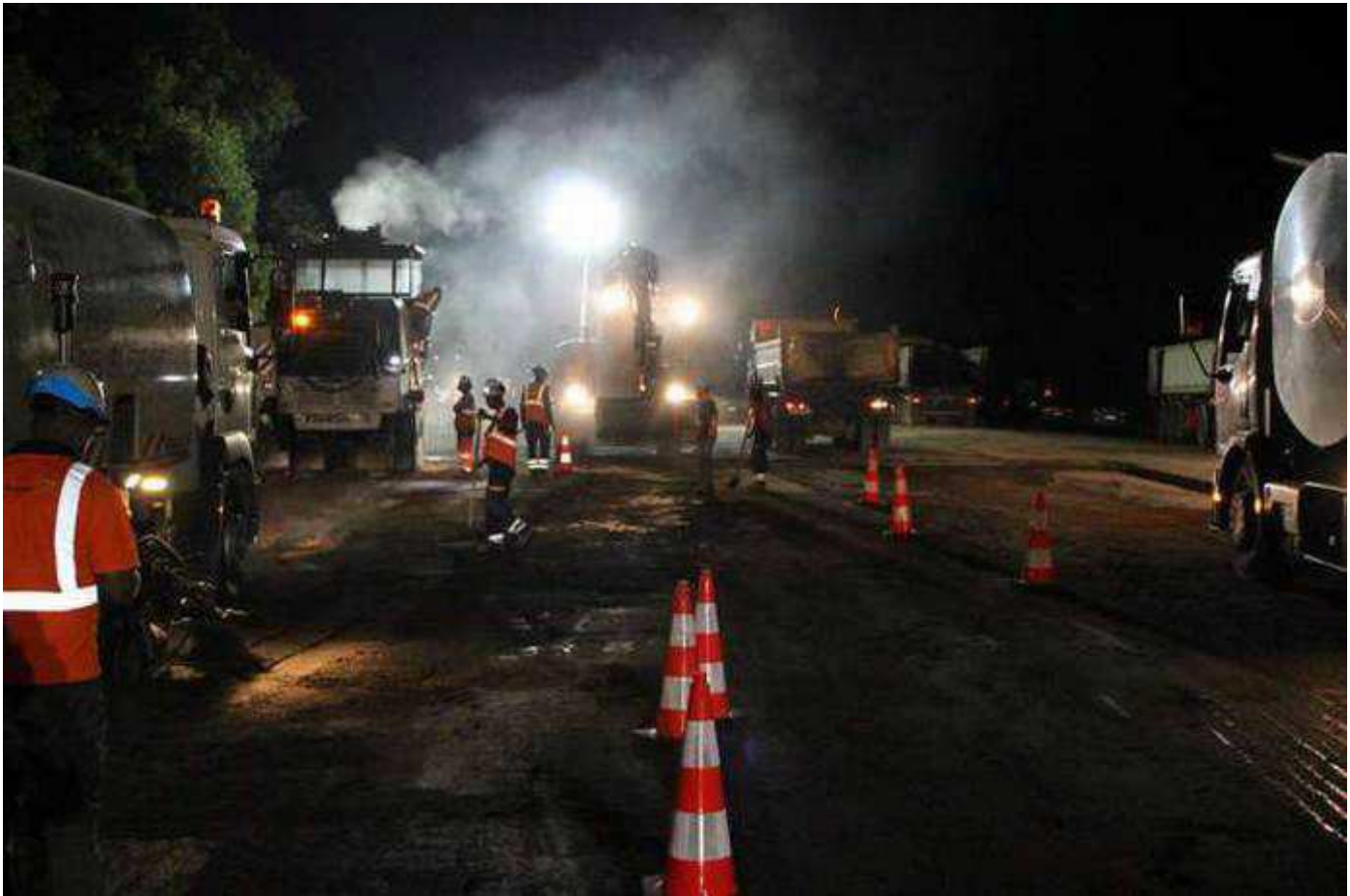
Rabotage de la chaussée et réalisation des enrobés – photo DIRSO
