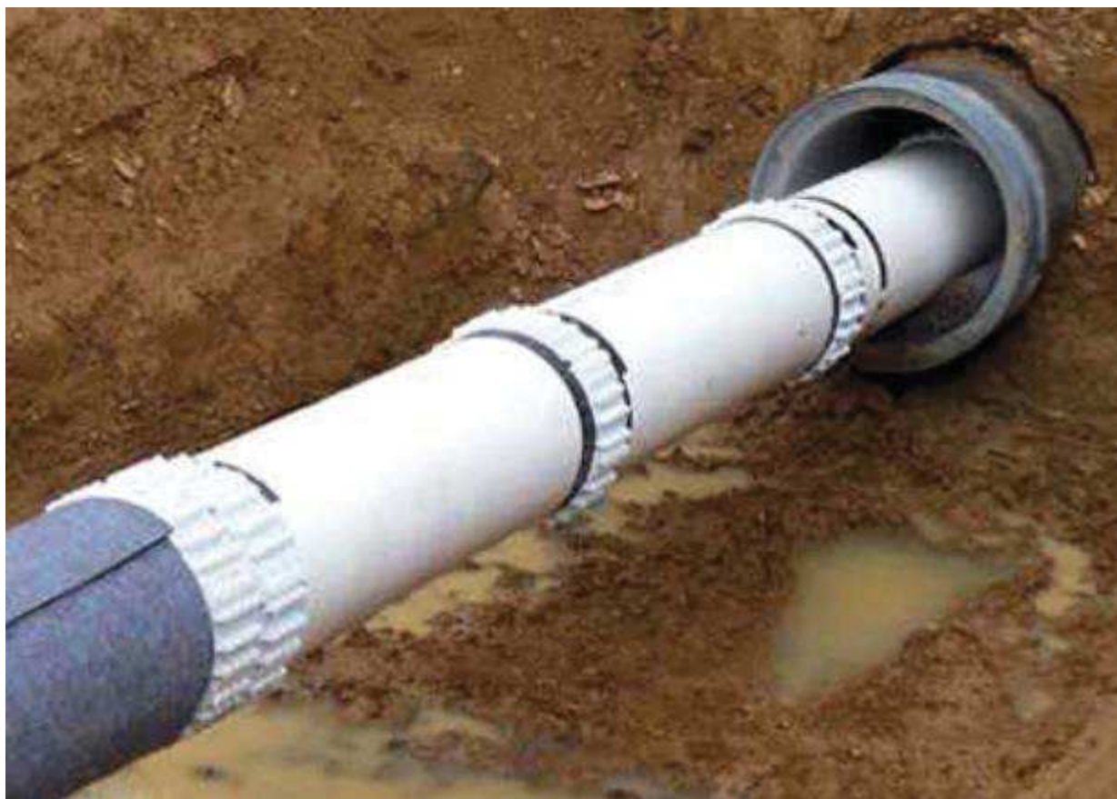
Tronçon de canalisation à l'intérieur d'un busage, implanté par fonçage taupe
