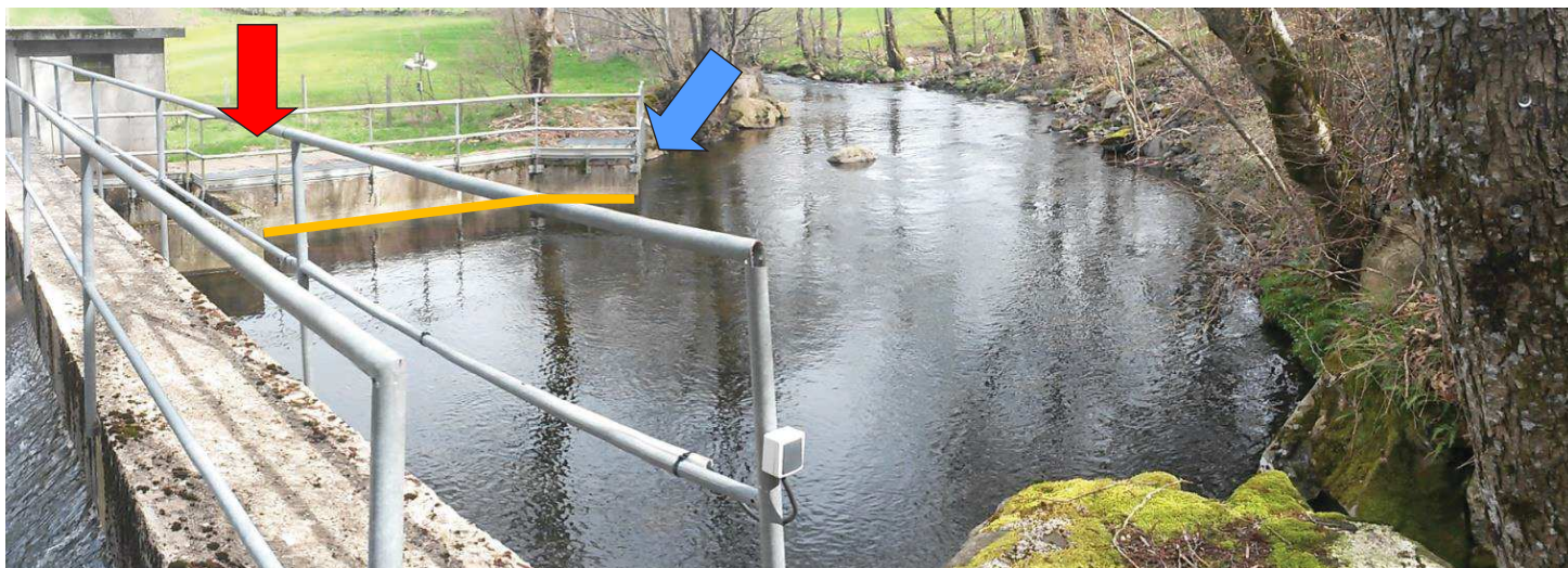
Figure 36 : Vue de la partie amont du captage d'eau des Touzes.
