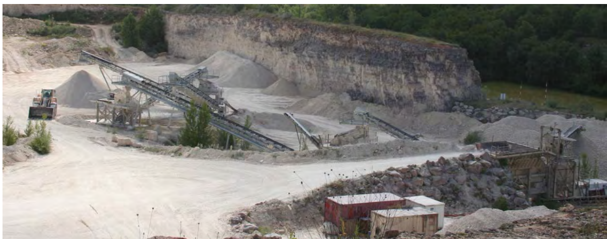
Installations de concassage-criblage
