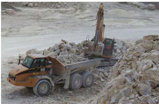
Reprise des matériaux à la pelle et au tombereau
