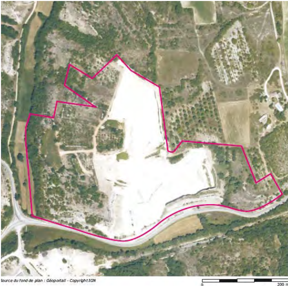
Vue générale aérienne de la carrière
