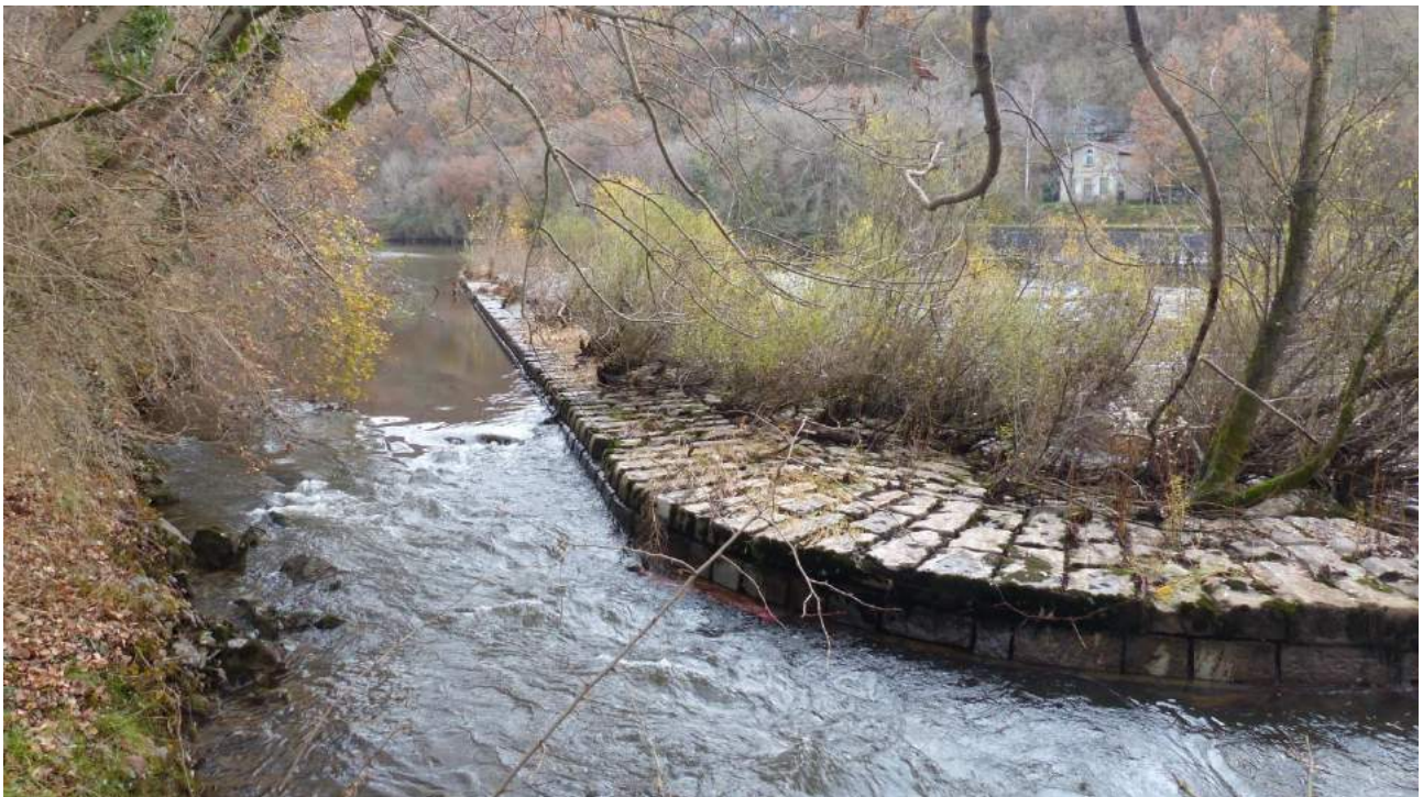
Figure 33 : Chenal en rive droite de Camboulan et zone de blocs colonisée par les Saules
