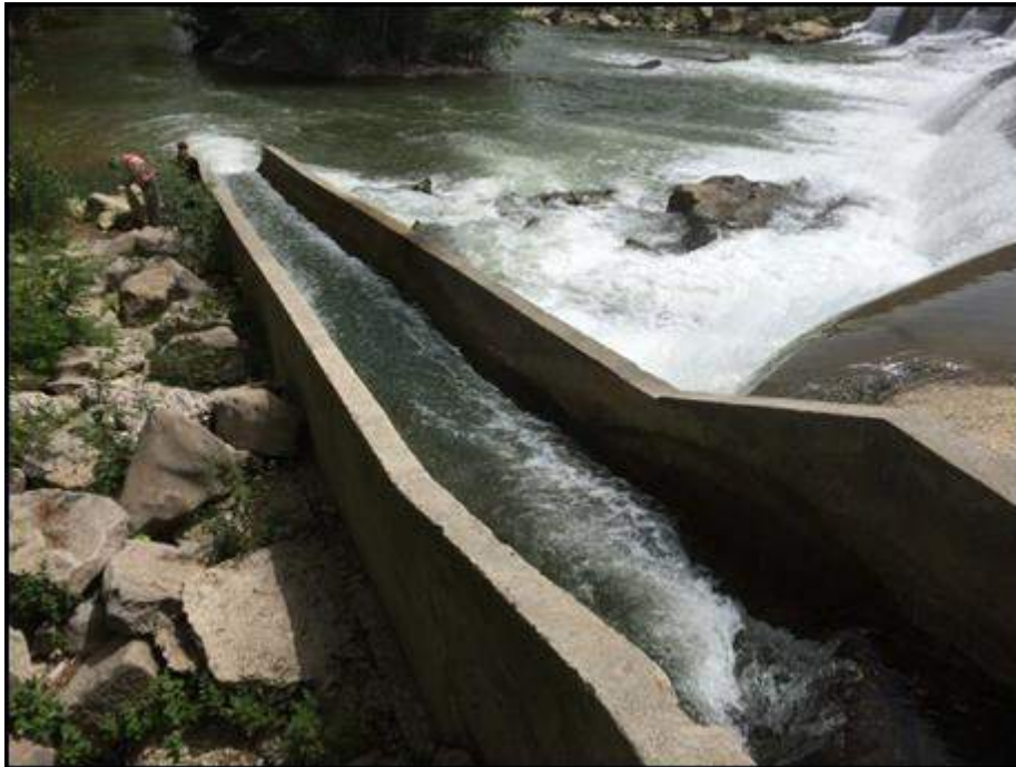
Figure 13 : Exemple de passage à canoë à fond lisse
