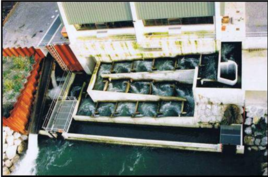
Figure 11 : Exemple d'une passe à poissons avec deux sorties hydrauliques
