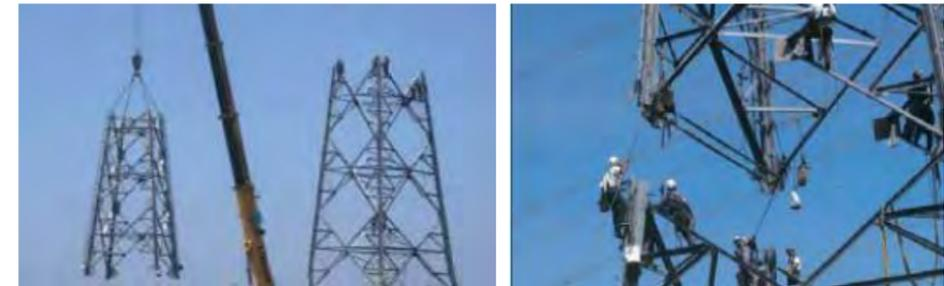
Figure 5 : Exemple de montage et assemblage d'un pylône (RTE, 2016)
