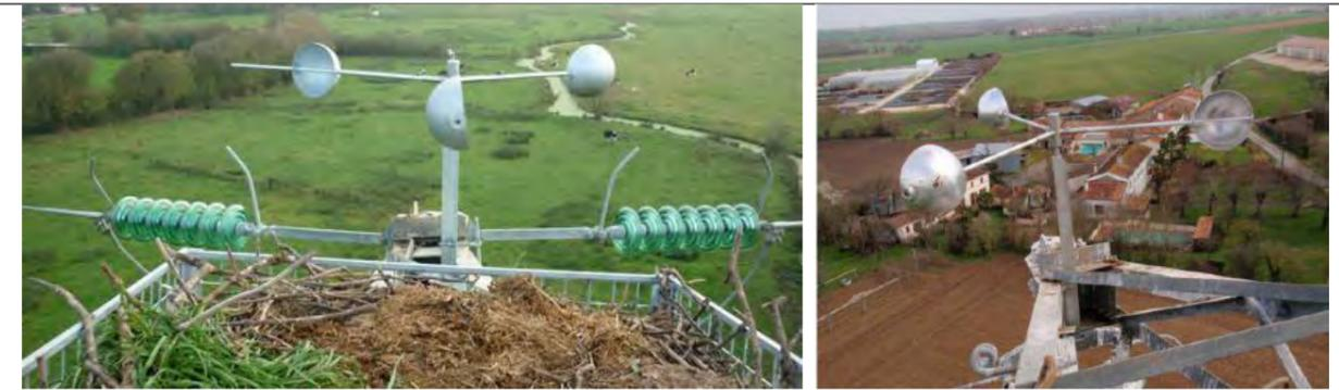
Figure 31 : Dispositif d'effarouchement en rotation (source : FISOLA et RTE)
