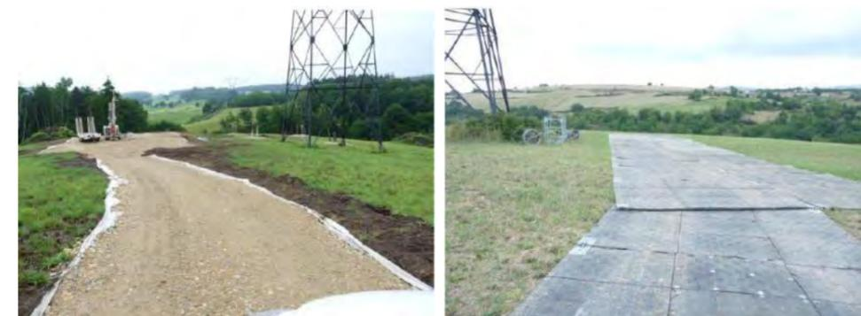
Figure 33 : Exemples de pistes provisoires, à gauche sur géotextile et à droite sur plaques
