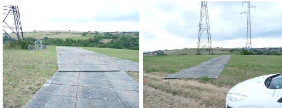
Figure 37 : Exemples de réalisation de pistes sur plaques (source : RTE)
