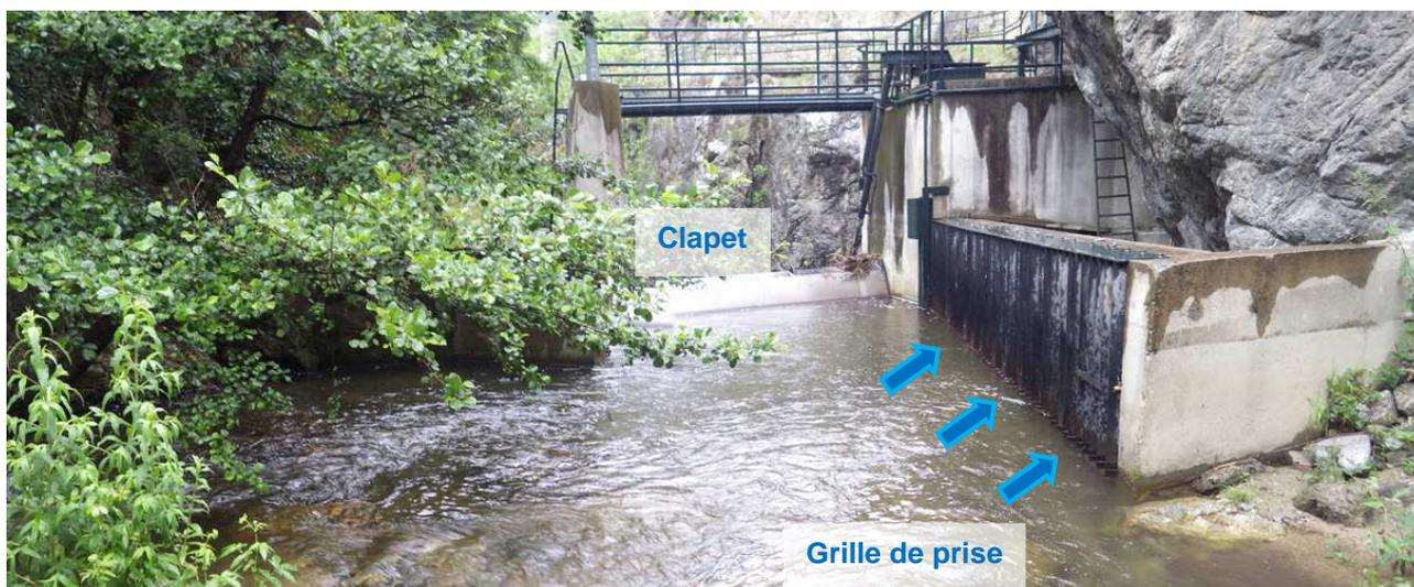
Figure 5 : Photo de la prise d'eau vue de l'amont
