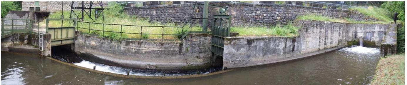
Figure 2 : Pré-grille de la prise d'eau et bassin de décantation menant au canal d'amenée
