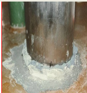
Enduits de rebouchage
