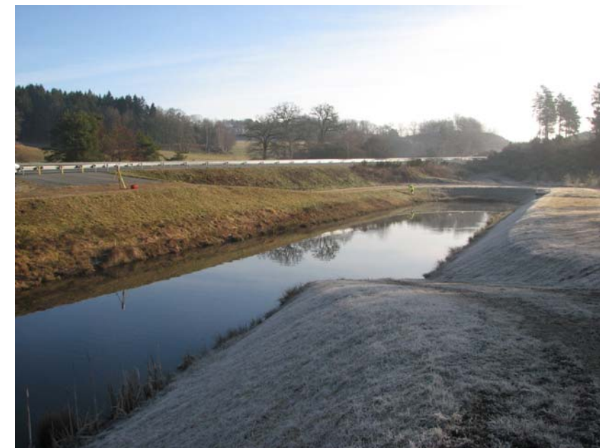
Figure 10 : Exemple de bassin multifonctions, source Egis
