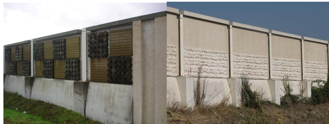
Figure 16 : Exemples d'écran acoustique, source Egis
