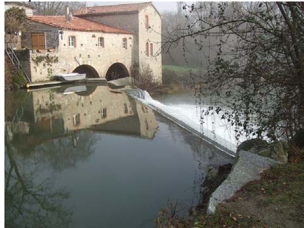
Photo 8 : le Sor à Cambounet (source Internet)
