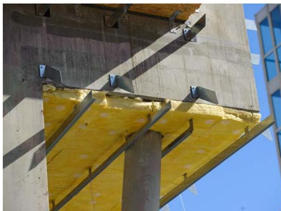
Pose d'isolant, qui constitue l'un des bouquets de travaux utilisés dans la rénovation énergétique des bâtiments
