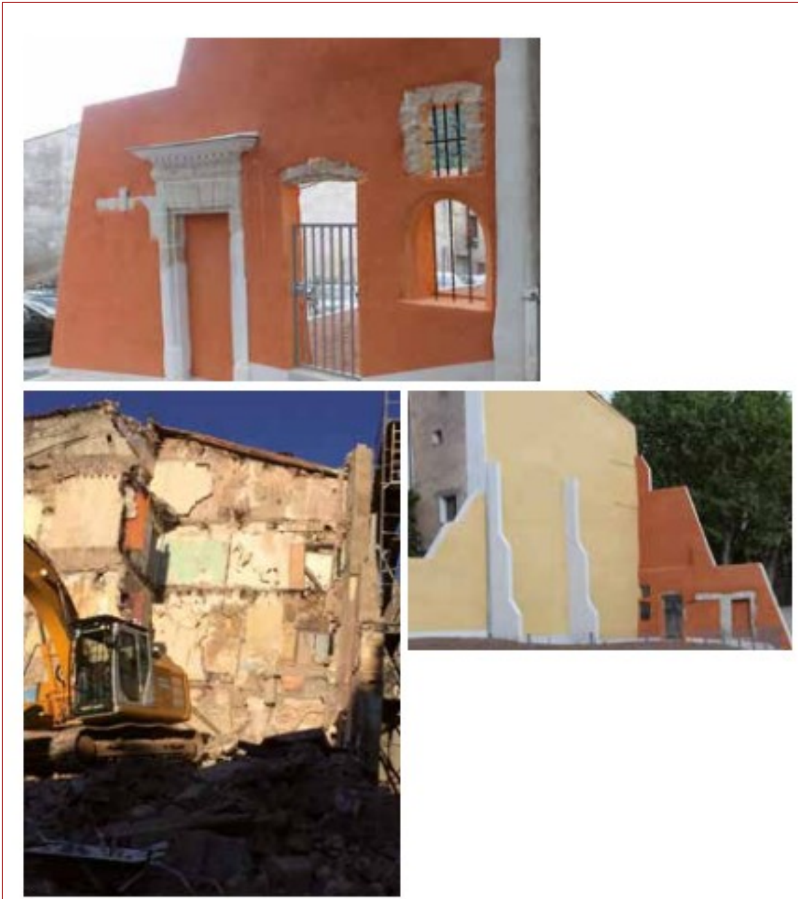
Travaux de rénovation de l'îlot d'Enoz Image : Ville de Clermont l'Hérault
