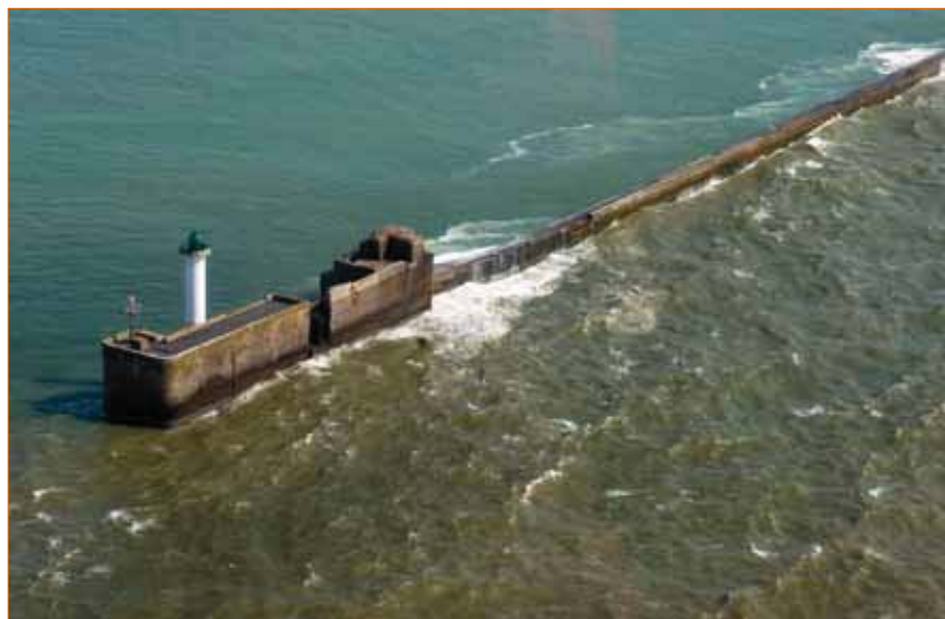
Digue à Boulogne-sur-Mer, dans le Pas-de-Calais (62).
