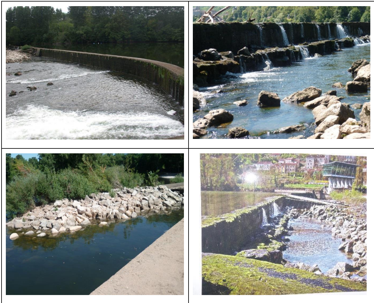
Figure 3 : Photos de la digue
