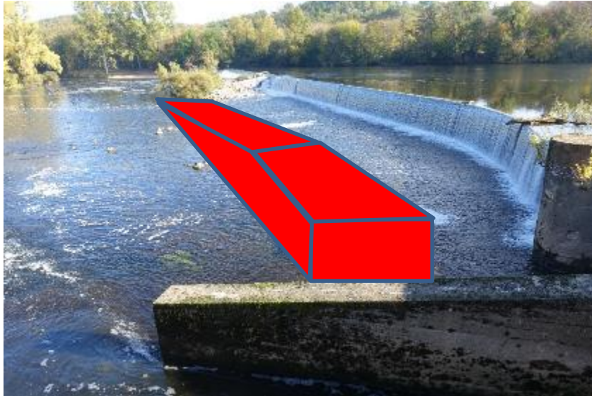
Figure 10: Vue aval digue Accès RG
