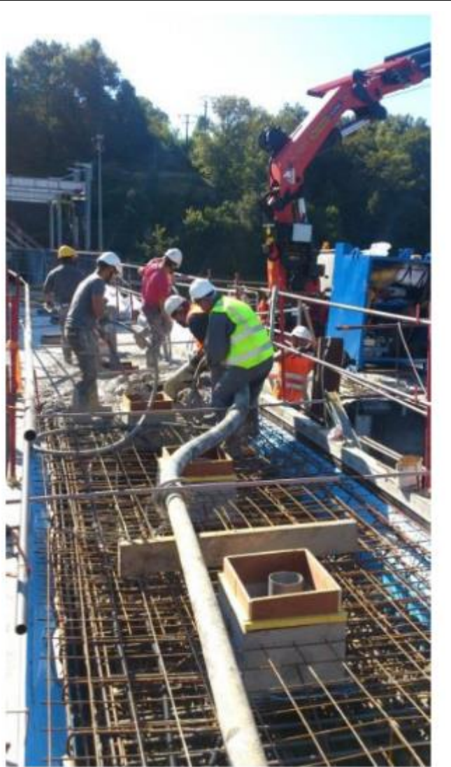
Figure 15 : Travaux bétonnage seuil
