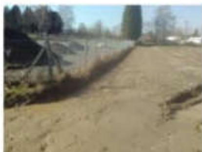
Photo 1 (création d'un accès)
