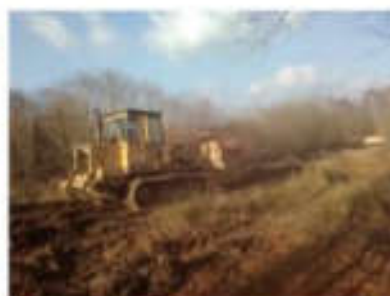
Photo 5 et 6 (évacuation et transport de matière inerte pour créer des merlons)
