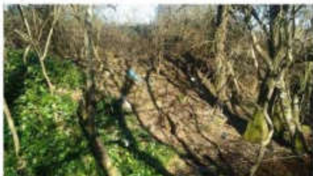
Limite entre la zone remblayée et le secteur à sol d'origine qui est matérialisé par un talus constitué de remblais et de déchets divers – dans la partie sud-ouest du site D – le 22 février 2017 (c'est dans le secteur Sud-Ouest du site D que le talus est le moins marqué avec environ 2 mètres de dénivelé, alors que la plateforme dépasse les 4 mètres d'épaisseur dans la partie Nord-Est.)
