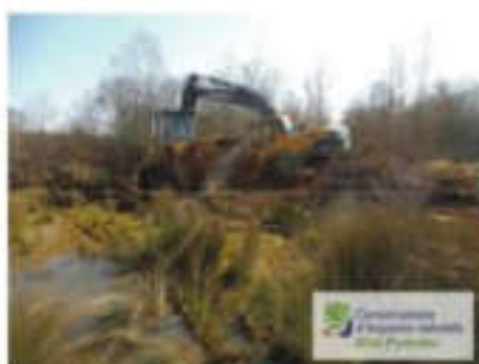
Photo 5 et 6 (évacuation et transport de matière inerte pour créer des merlons)
