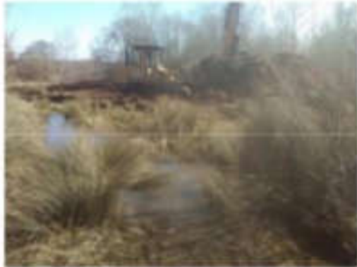
Photo 9 (Évitement des mares temporaires situées sur l'ancienne piste)
