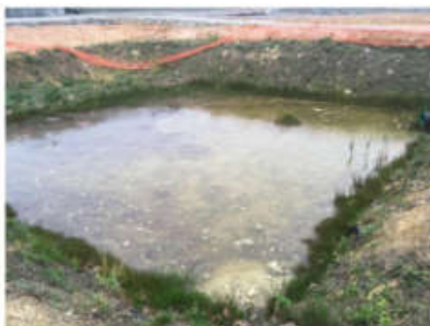
Bassin de décantation
