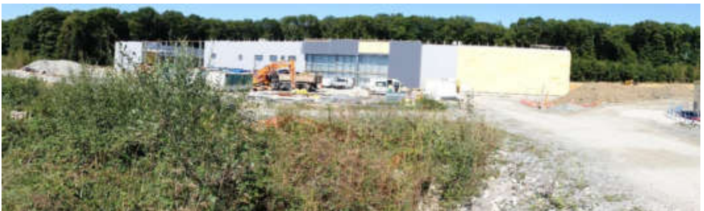
Le chantier en septembre 2018
