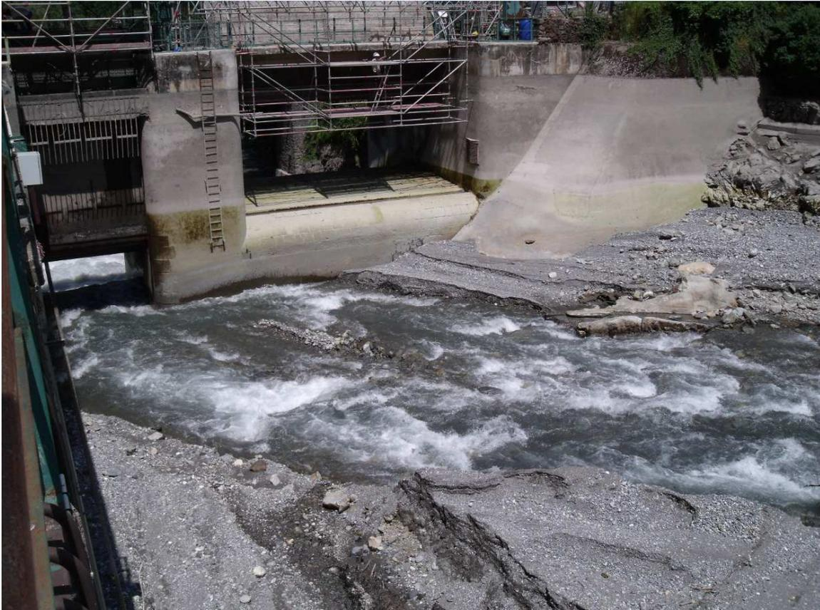
Figure 18 : Matériaux accumulés en pied de barrage (vidange 2009) – Vanne de fond à gauche
