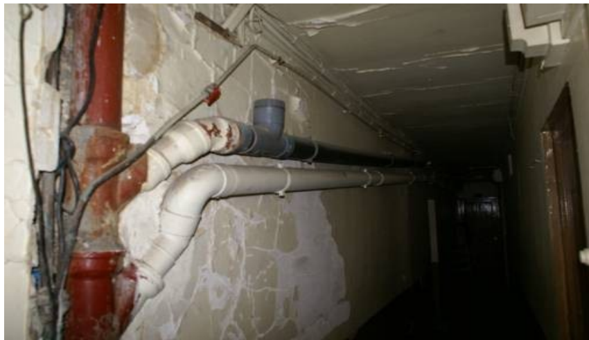
DREAL Occitanie - Direction Aménagement/Division Habitat
