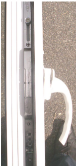
② Fermeture centrale (crémone et tringle)
