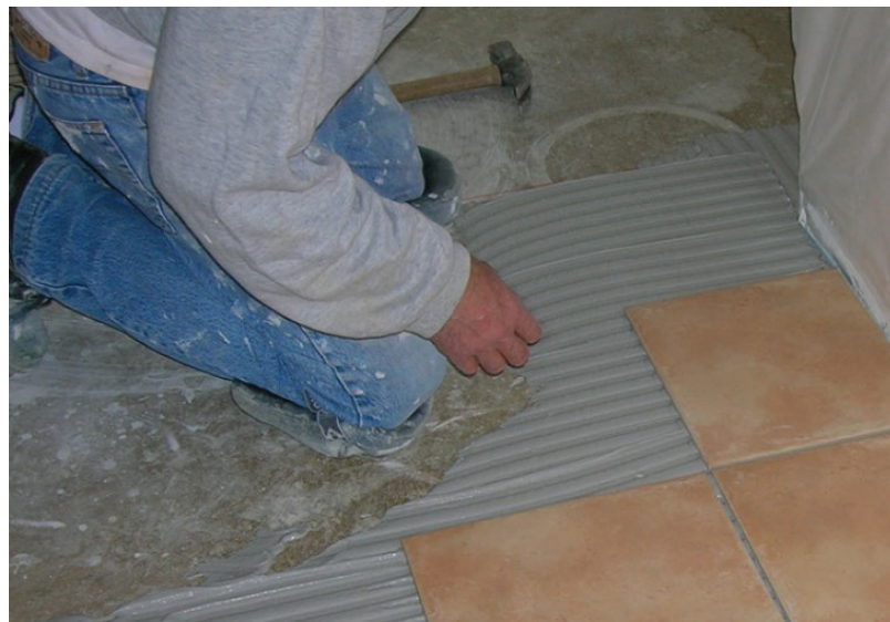
Figure 49 : Pose à la colle
