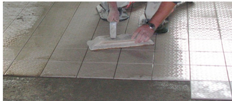
Figure 41 : Battage des carreaux pour assurer le scellement
