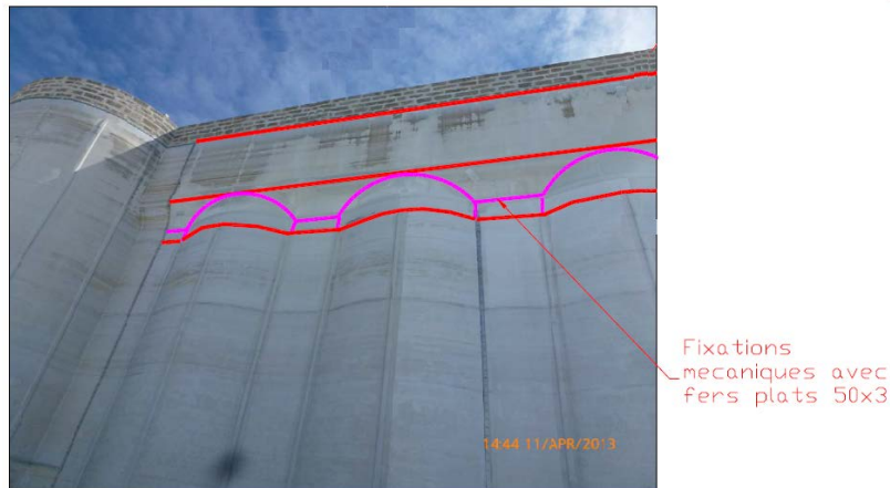
Schéma des fixations aux changements d'angles de la structure.
