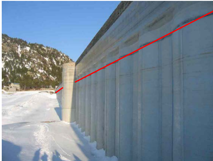
Barrage de Bouillouses. En rouge, la ligne de connexion entre le géocomposite Carpi en partie basse des voutes, et le nouveau géocomposite Carpi en partie haute.
