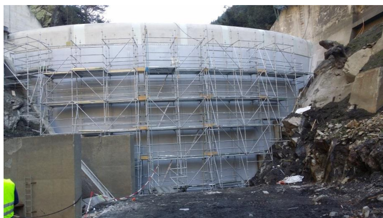
Figure 9 : Exemple de mise en place d'une membrane PVC sur parement de barrage
