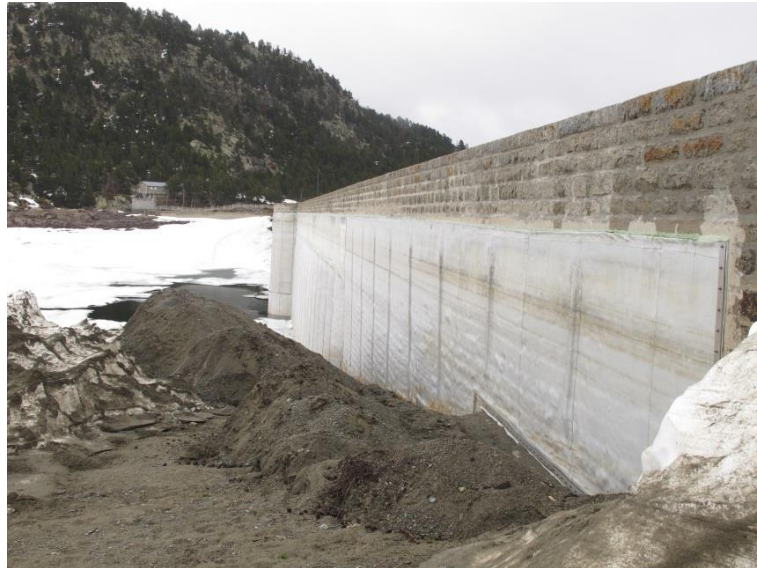
Figure 6 : membrane PVC existante à déposer et remplacer
