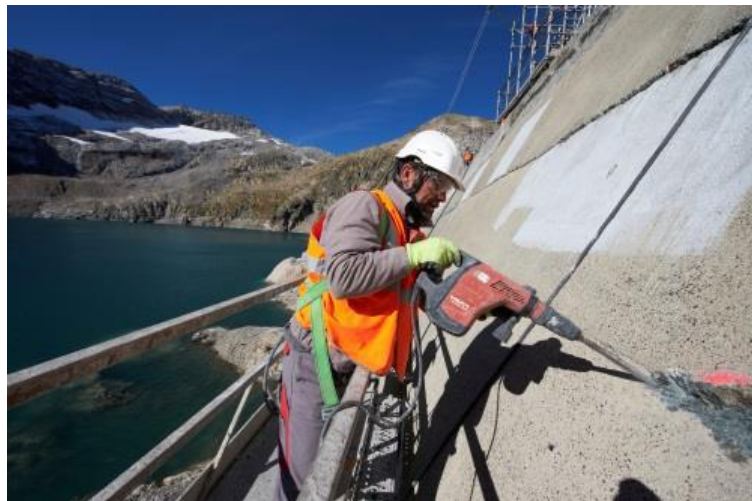
Figure 7 : Repiquage des bétons dégradés
