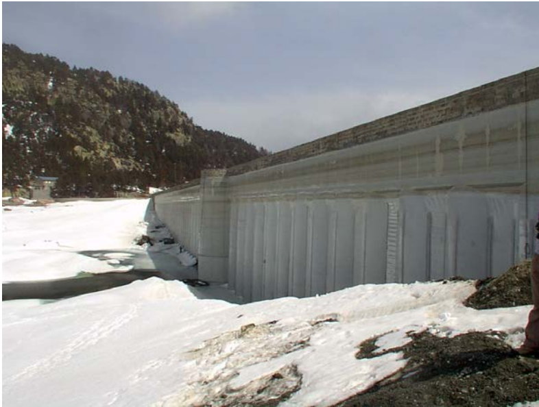
Barrage des Bouillouses
