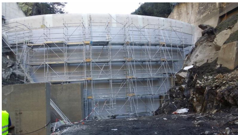
Membrane d'étanchéité sur parement amont
