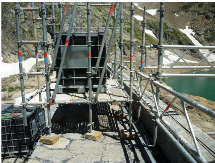
Figure 3 : Echafaudage suspendu avec leste
