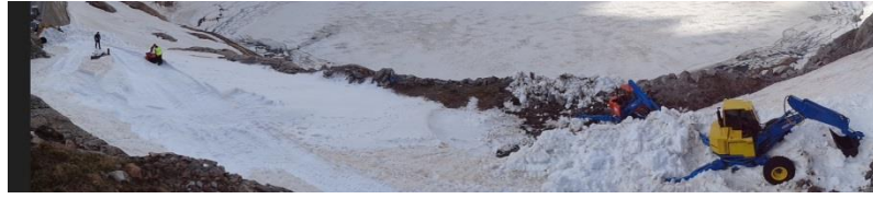
Travaux de déneigement
