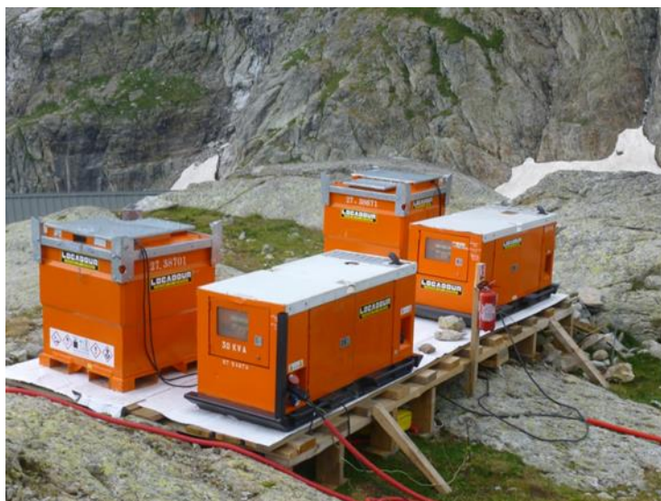
Atelier de production avec bac de rétention intégré
