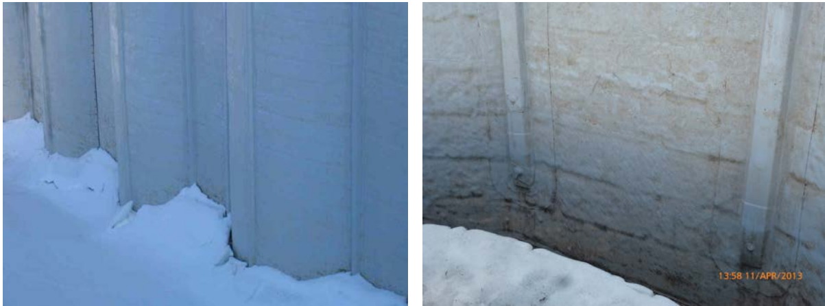
Barrage de Bouillouses. La charge hydraulique a imprimé le géocomposite sur le géodrain et le système de fixation.
