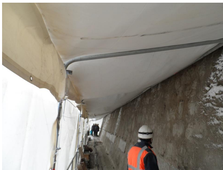
Figure 5 : Bâche de protection d'échafaudages
