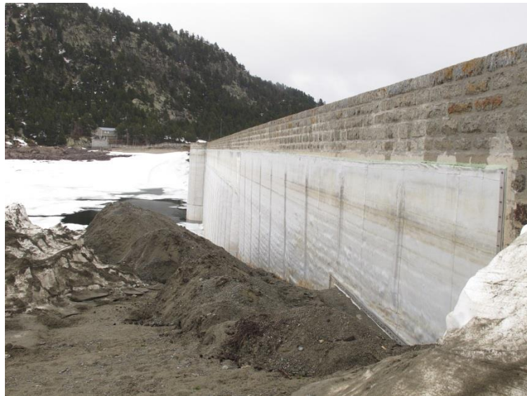
Membrane en tête à remplacer
