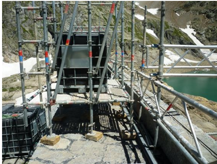
Échafaudage suspendu avec lestes
