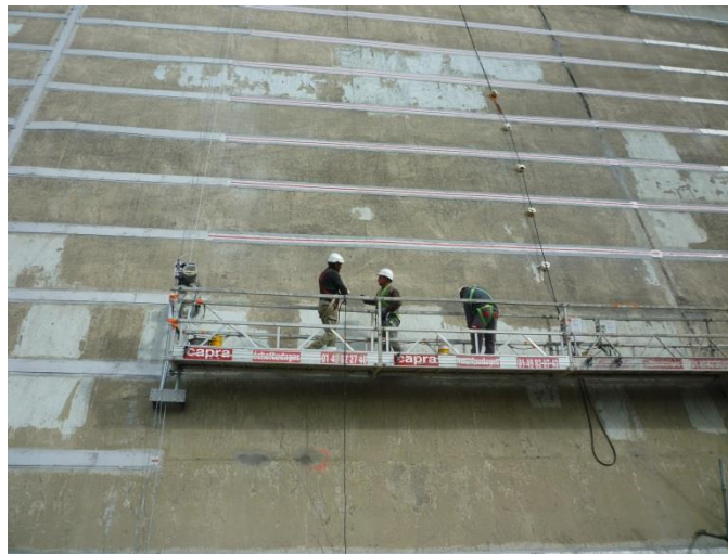
Réparation du parement béton
