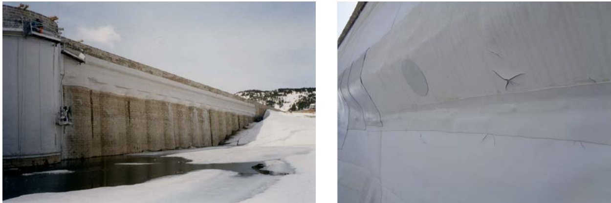
Barrage de Bouillouses. A gauche la partie haute étanchée avec membrane SIKA, lors de l'installation de la membrane CARPI sur le puit. A droite, la membrane SIKA à l'état actuel : les petites ruptures "en étoiles" sont typiques d'un matériau qui a vieilli et ne conservant plus sa flexibilité.
