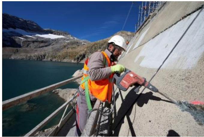
Repiquage des parements bétons
