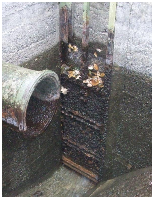
Figure 10 : Photo de la vanne de chasse 0.50x0.50 m à déposer et à remplacer
