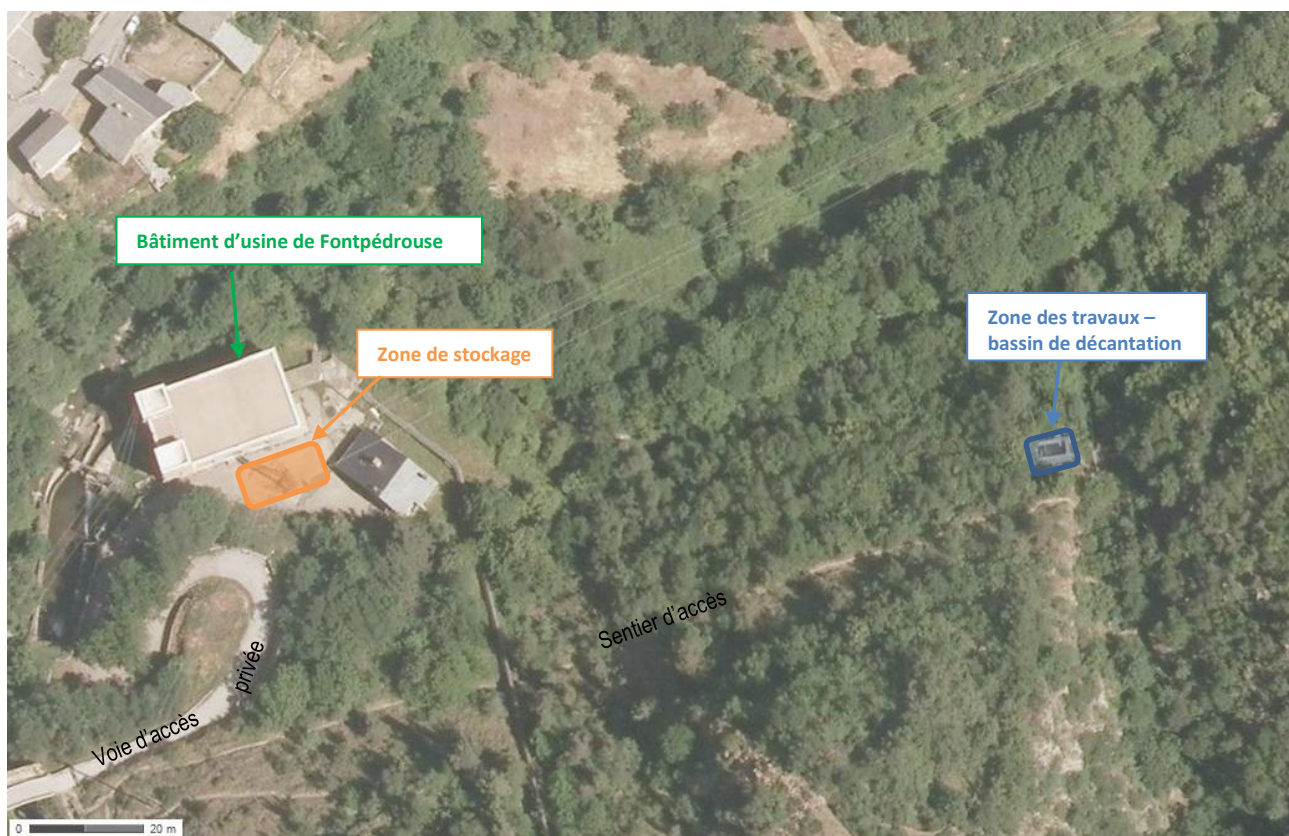
Figure 5 : Vue aérienne – Zone de travaux et de stockage
