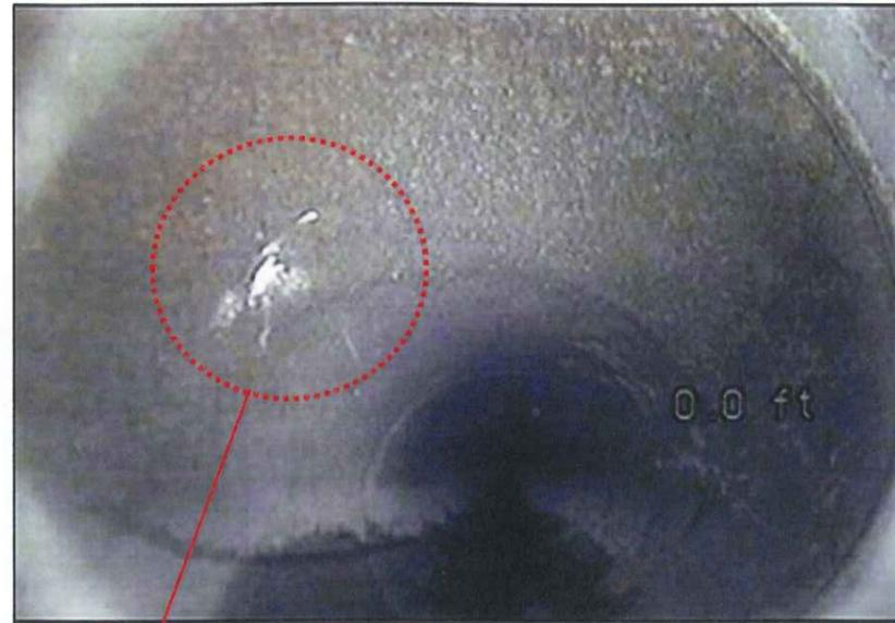
A environ 15 cm de la fenêtre de visite présence d'un trou sur la conduite, également visible sur l'extérieur de la conduite
