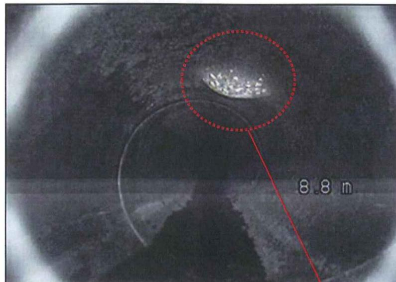
A 9,00 m de la sortie vidange, présence sur le haut de la conduite d'un poinçonnement certainement percé sur plusieurs points (points blanc)
