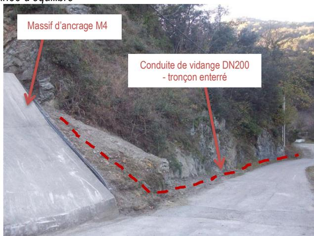
Figure 5 – Partie enterrée de la conduite de vidange de la cheminée d'équilibre au-delà du massif d'ancrage M4
