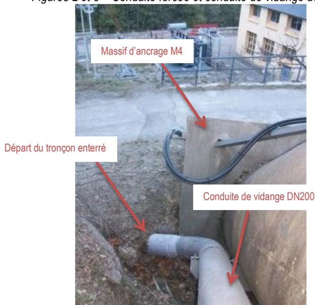
Figure 4 – conduite de vidange de la cheminée d'équilibre et massif d'ancrage M4
