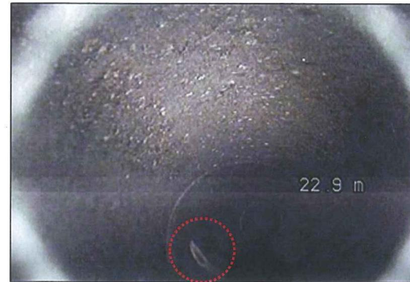
A 22,9 m de la fenêtre de visite, présence sur le bas de la conduite d'une tâche blanche pouvant indiquer la présence d'une fissuration sur tout le contour du cercle (zone la plus claire)
