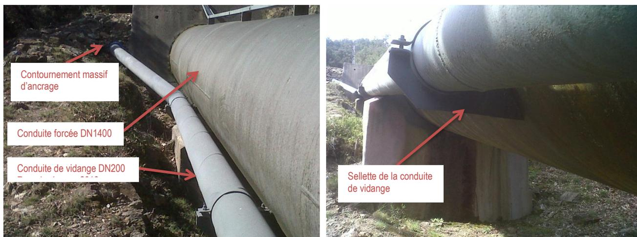
Figures 2 et 3 – Conduite forcée et conduite de vidange de la cheminée d'équilibre
