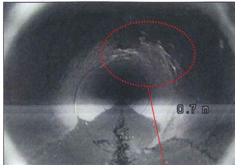
A 70 cm de la fenêtre de visite trace de corrosions sur l'intérieur de la conduite
