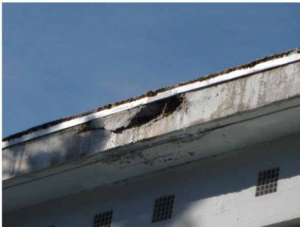
Figure 4 : Vue du débord béton dégradé – Détail
