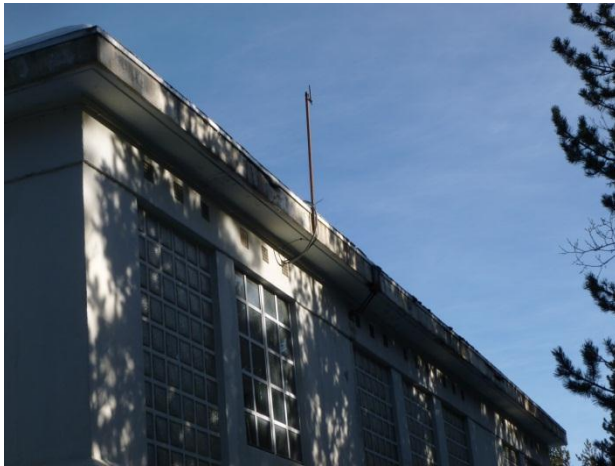
Figure 2 : Vue du débord béton dégradé – Façade ouest
