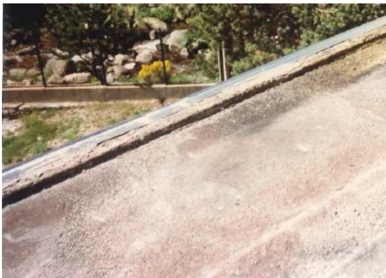
Figure 9 : Chape existante du toit terrasse – vue de la bande de rive et du léger relevé
