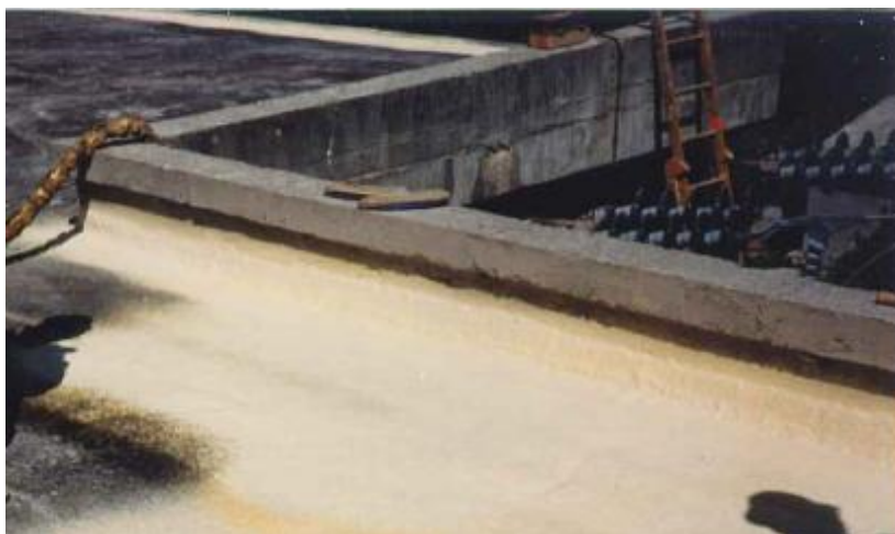
Figure 10 : Toit terrasse – vue sur l'acrotère à proximité du transformateur
