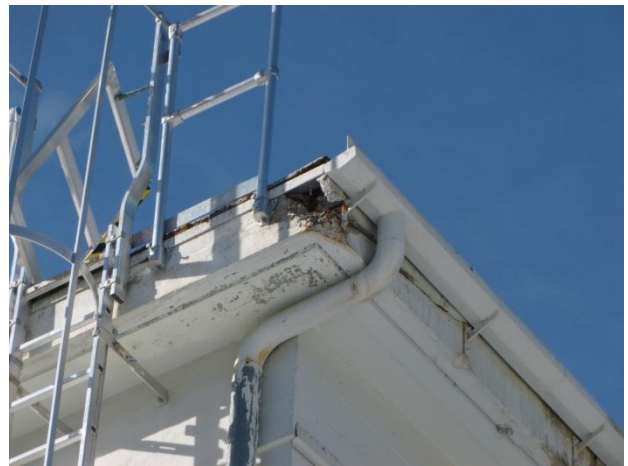
Figure 5 : Vue du débord béton dégradé – Détail cheneau - façade est
