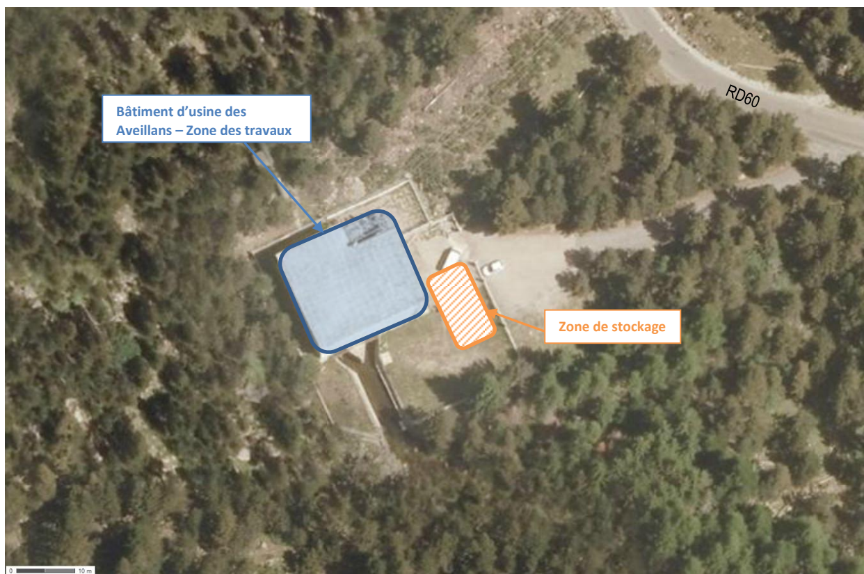
Figure 8 : Vue aérienne du bâtiment d'usine des Aveillans – Zone de travaux et de stockage des déchets
