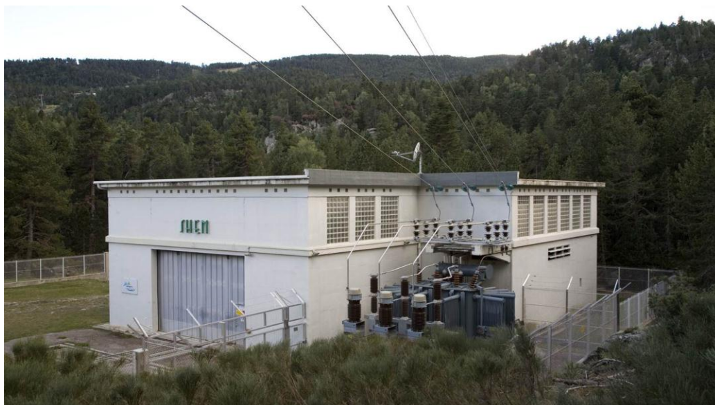
Figure 6 : Photo du bâtiment d'usine – Vue sur le transformateur et la ligne d'évacuation Haute Tension 63 kV
