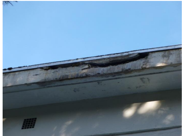
Figure 3 : Vue du débord béton dégradé – Détail
