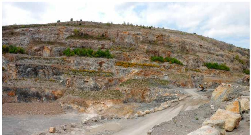
Exploitation et réhabilitation progressive de la carrière par le processus d'exploitation et des semis sur banquettes.
