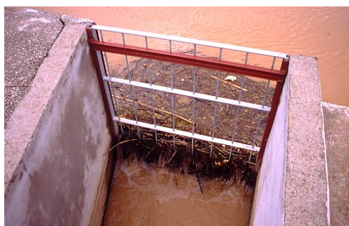
Sortie de passe à poissons obstruée par les déchets
