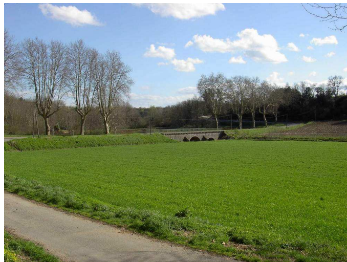
Photo 5 : Remblai barrant la plaine alluviale
