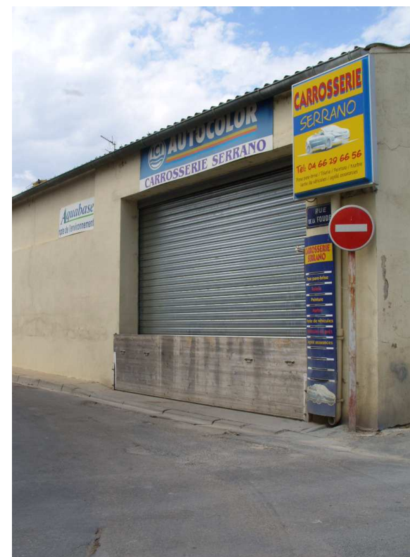
A Saint-Gilles, le ruisseau de la Garonnette a causé de forts dommages à maintes reprises. Certains habitants et commerçants, conscients du risque, disposent de batardeaux pour protéger leurs locaux.
