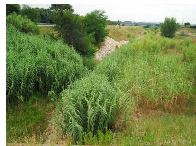
Le chenal construit pour dévier le Rieuprimen, au sud du contournement de Pont Saint-Esprit
