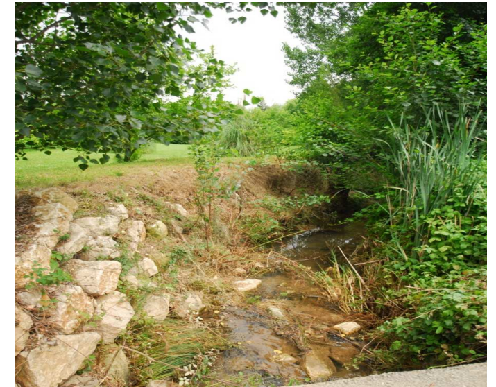
L'Arnavé au lieu dit Mas Cousit, enrochée en amont d'un ouvrage de faible dimension
