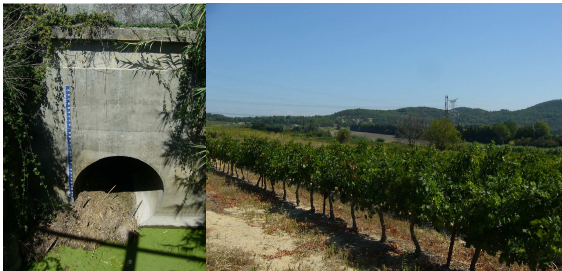
Entrée de l'ouvrage souterrain drainant la dépression de la Palud et vue de la dépression
