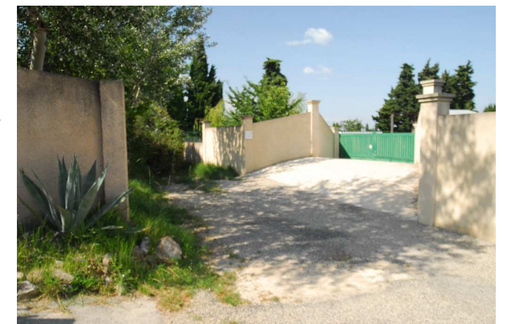
En guise de protection contre les crues, un merlon devant l'entrée de la propriété permet la déviation des eaux lorsque leur hauteur n'est pas excessive
