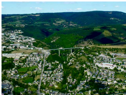
Viaduc de Rieucros
