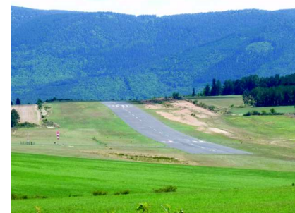
Piste de l’aéroport de Mende-Brénoux
