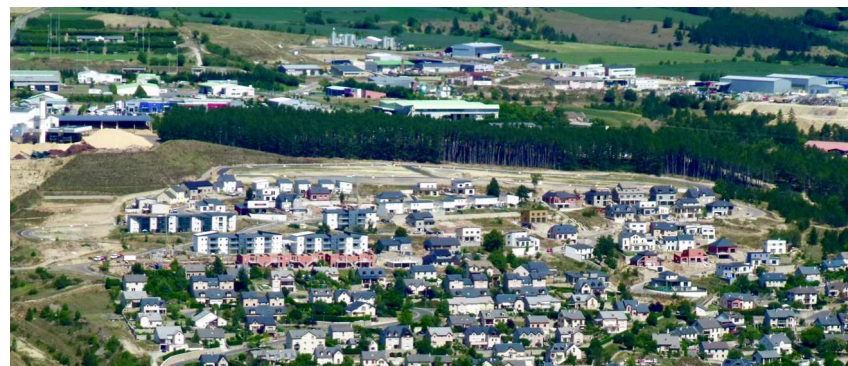
Vue générale sur le quartier des Hauts de la Bergerie et sur la ZAE du Causse d’Auge
