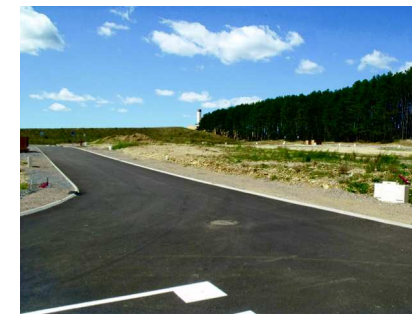
Extension des Hauts de la Bergerie, en cours de bornage.
