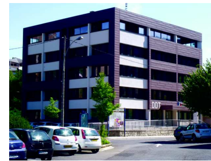
Direction Départementale des Territoires
