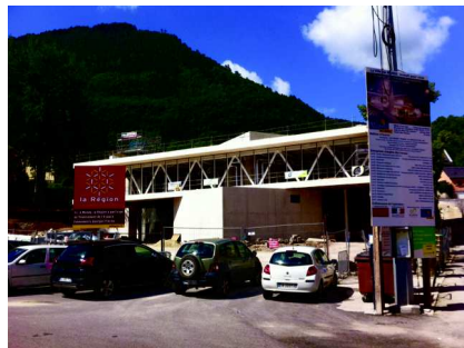
Espace Evénement Georges Frêche en cours de construction
