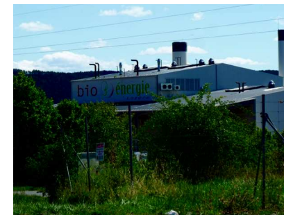
Usine de cogénération implantée sur le causse d'Auge
