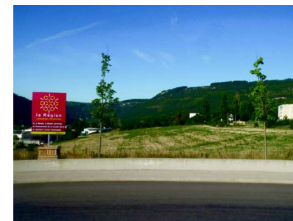
Emprise de la future Rocade Ouest de Mende au niveau de son branchement avec le giratoire du viaduc de Rieucros
