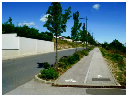
Cheminement doux avenue Nelson Mandela
