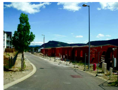
Constructions en cours dans le quartier des Hauts de la Bergerie
