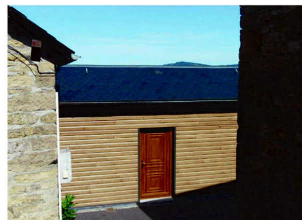
Extension bâtie dont les formes et matériaux s’accordent peu avec les caractéristiques du bâti traditionnel
