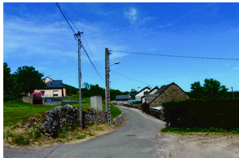
Juxtaposition d’éléments (réseaux aériens, haie monospécifique, maison isolée sur grande parcelle) entraînant une perte de lisibilité du caractère patrimonial du hameau
