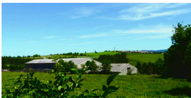
Hangar agricole de couleur claire créant un point d’appel du regard dans le grand paysage
