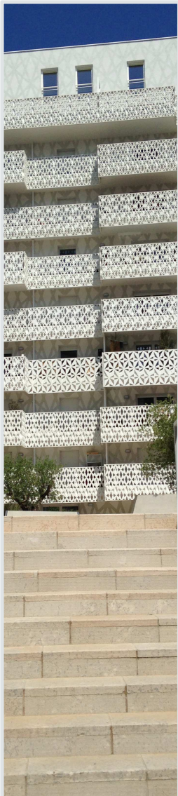
Opération "La Mantilla" livrée à Montpellier par Pragma à ACM Habitat.
