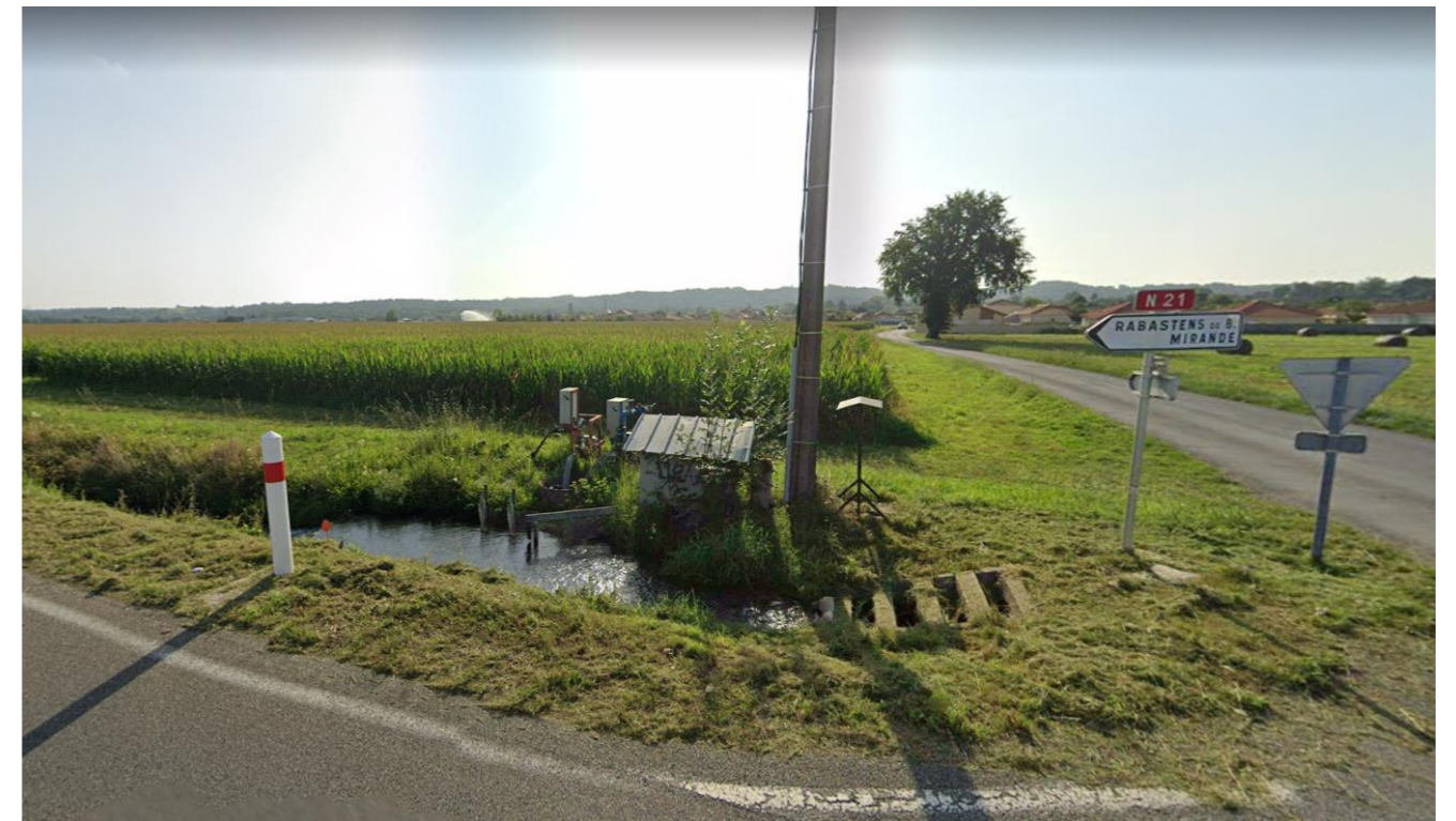
FOSSÉ LE LONG DE LA RN21 ET STATION DE POMPAGE ARCADIS®
