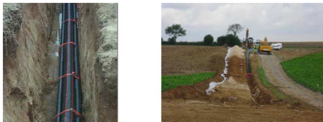
Figure 4 : Exemple de pose en milieu agricole
