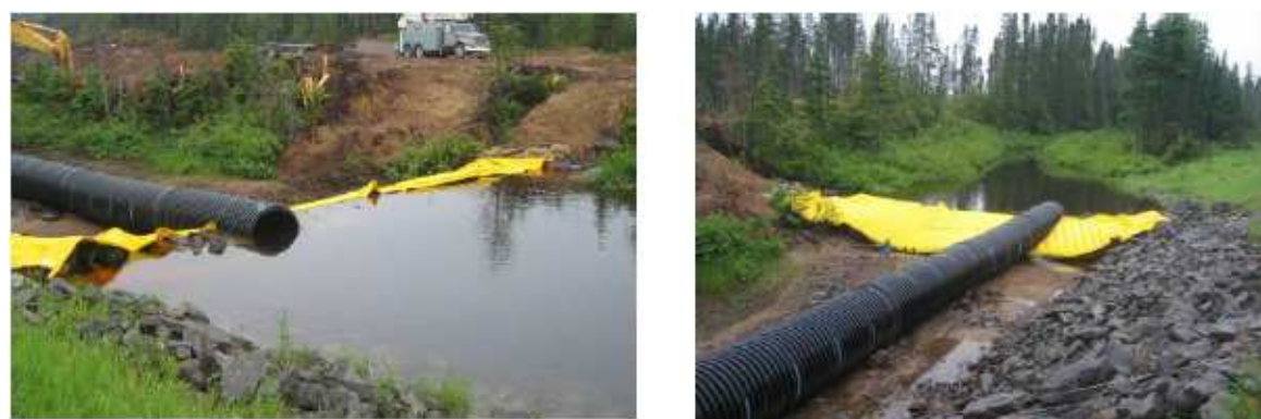
Figure 6 : Exemple de batardeau
