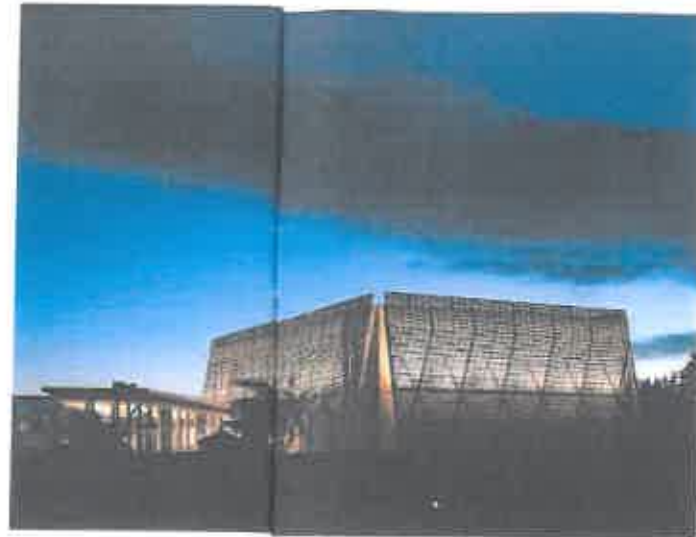
La nuit, un rétro-éclairage, par des projecteurs situés entre les deux parois, révèle la trame géométrique de la résille bois.
