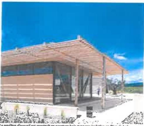
Le pavillon d'accueil est construit en ossature bois avec une isolation en fibre de bois et ovate de cellulose. Il fait également office d'espace d'exposition, parfois de coulisses de la salle de spectacle attenante.
