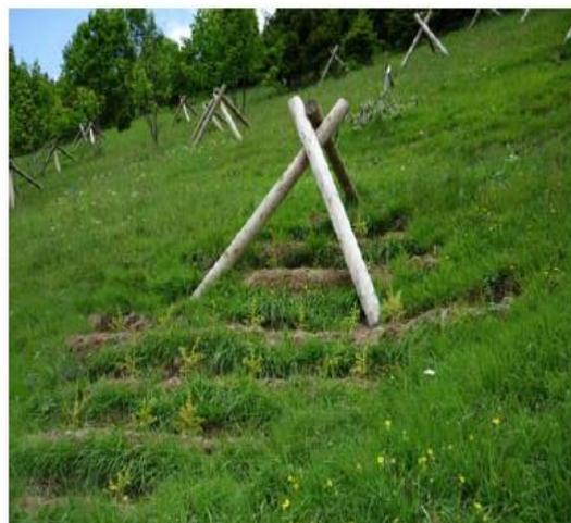
Figure 5 : Exemple de schéma de mise en œuvre des plantations et tripodes au sein d'un collectif (Source Istea et RTM73)
