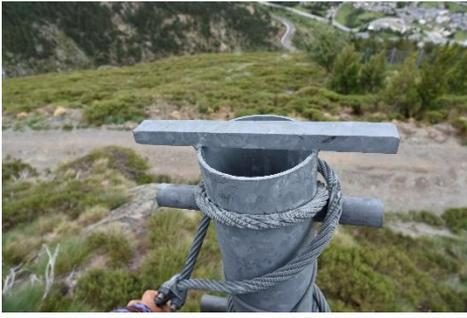
Ci-contre, les têtes de poteaux ouvertes constituent des pièges pour les passereaux.
