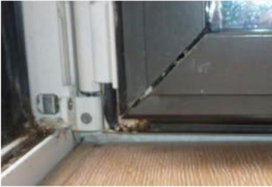
Assemblage d'angle défaillant et laissant apparaître des défauts de calfeutrement (Crédit photo: Saretec)
